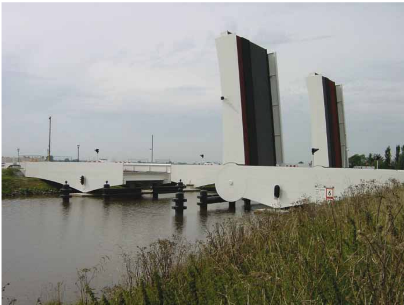
Nieuwe basculebruggen over het Reitdiep
