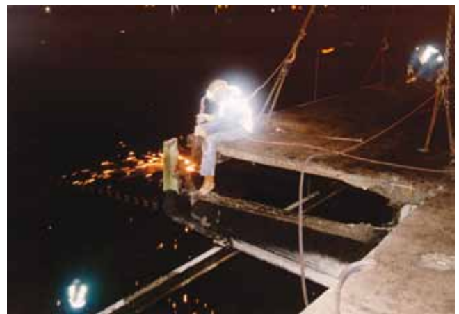
Slopen betonnen voetpad
