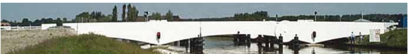
Boven: Het draaipunt ligt op een overkraging van de aanbrug. Onder: Overzicht
