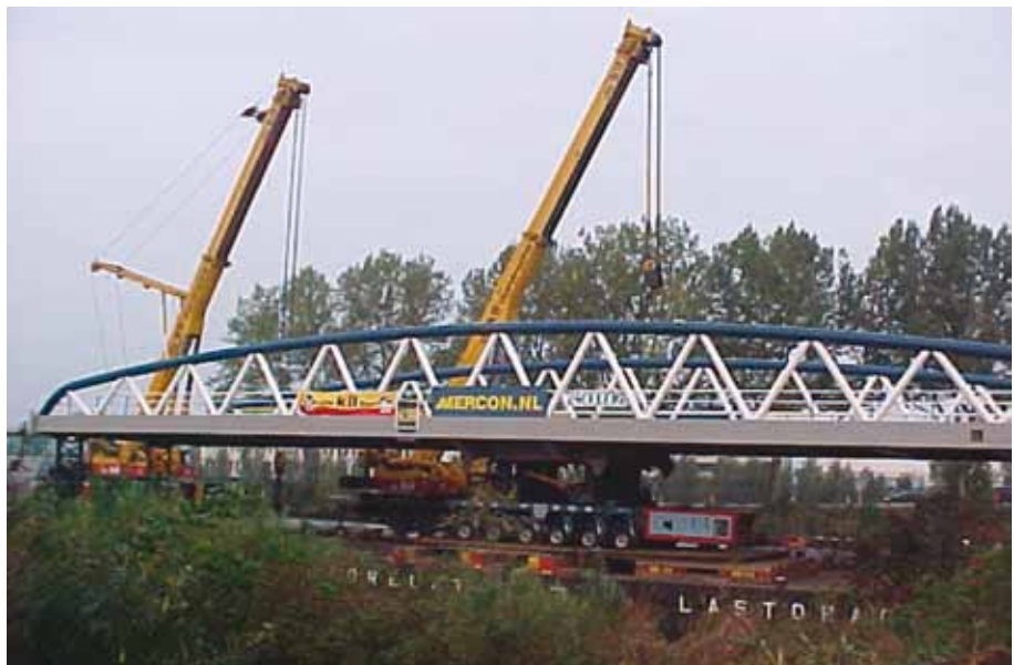
Inhijzen nieuwe brug
