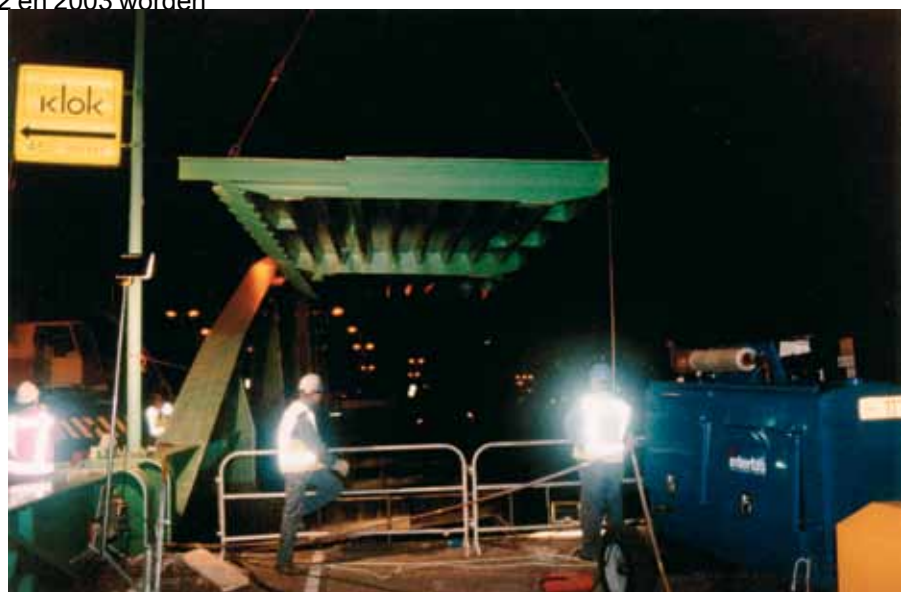
Aanbrengen nieuwe stalen voetpad
