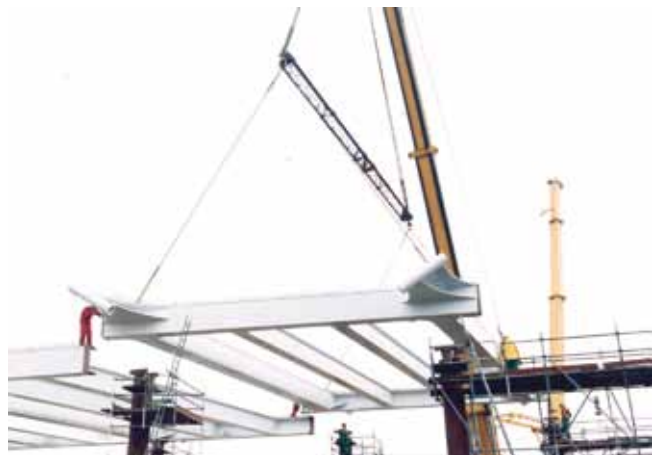
Inhijzen brugdeel. Let op aansluitingspunt voor de tuikabel
