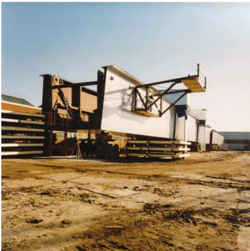
Montage veldligger in Schiedam
