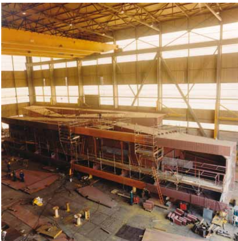
Montage hamerligger in Krimpen
