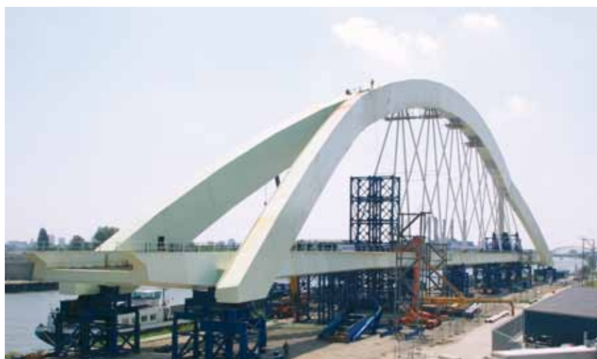
Nieuwe Demka spoorbrug in aanbouw Foto: Ciska Klooster
