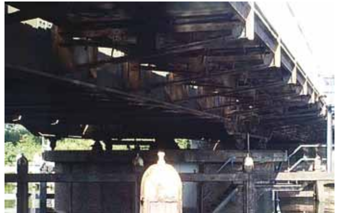
Onderzijde oude brug met draaipijler
