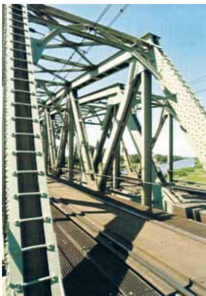
Spoorbrug bij Kelpen
