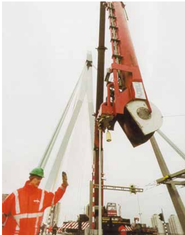
De cilinder wordt uit de kelder gehesen
