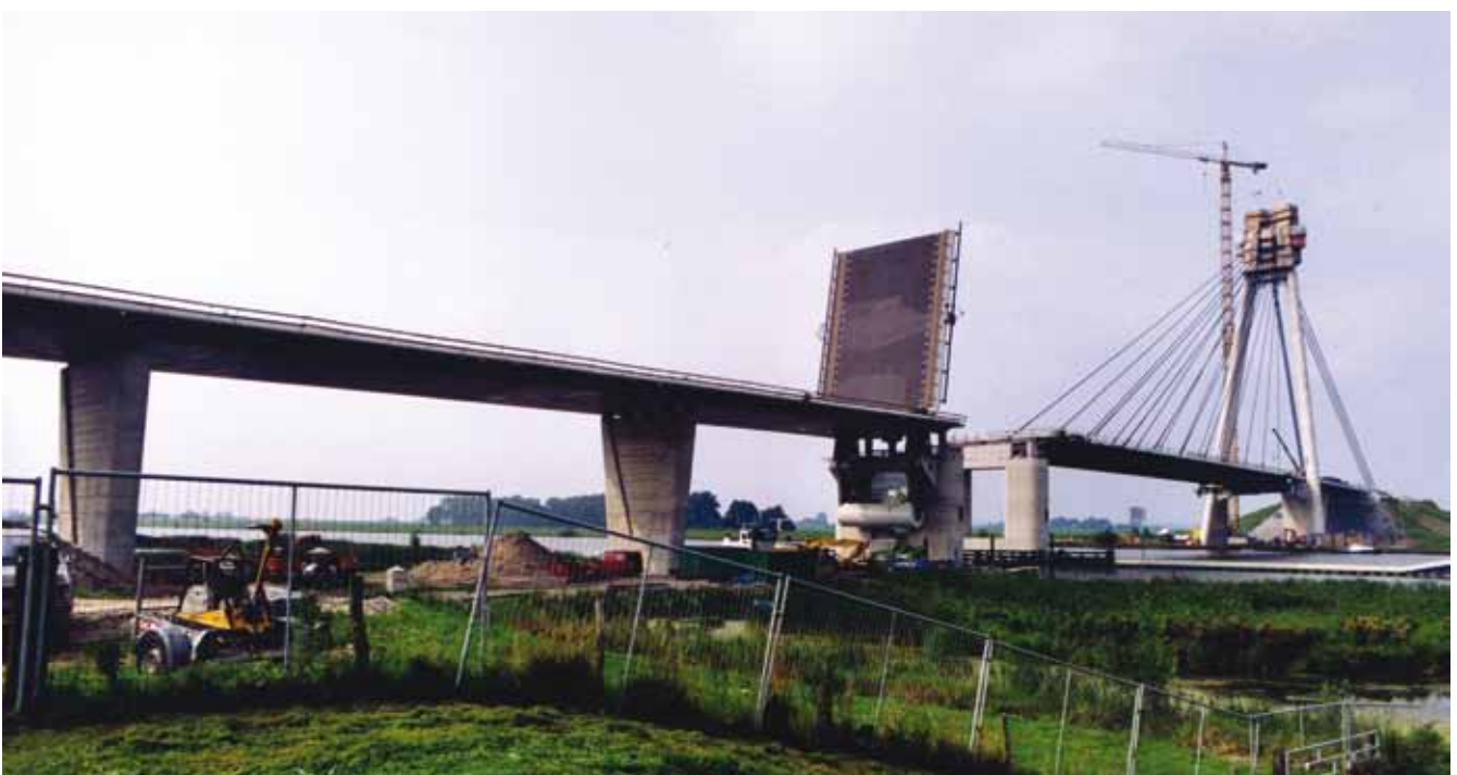
De Eilandbrug in Kampen in aanbouw. Foto H. Klooster
