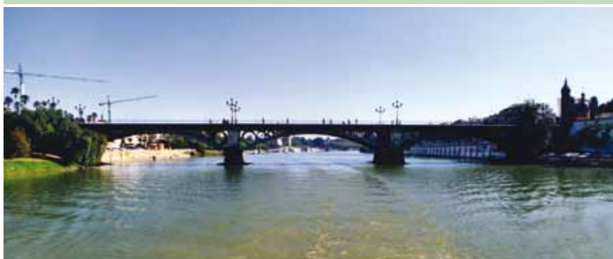
Oude ijzeren brug "Isabel II" over de Rio Guadalquivir in Sevilla, Spanje. Foto H Klooster
