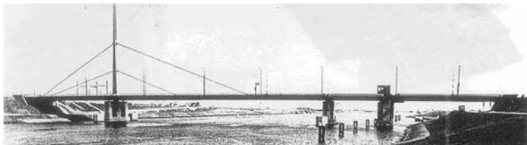
Figuur 13. Aanzicht Harmsenbrug
