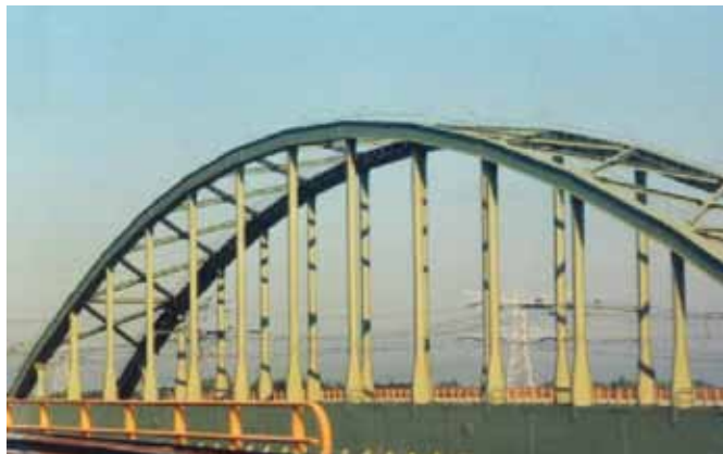
Figuur 11. Spoorbrug over het Schelde-Rijn kanaal (Kreekrak). Karakteristieken: verticale hangerconfiguratie; hangers uitgevoerd als samengesteld I-profiel; boven(wind)verband.
