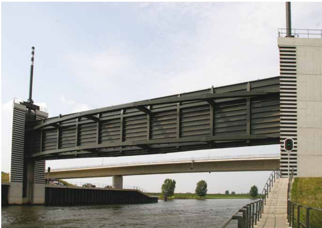
Keerschuif in geheven stand met naastgelegen kokerliggerbrug (foto: Ciska Klooster)
