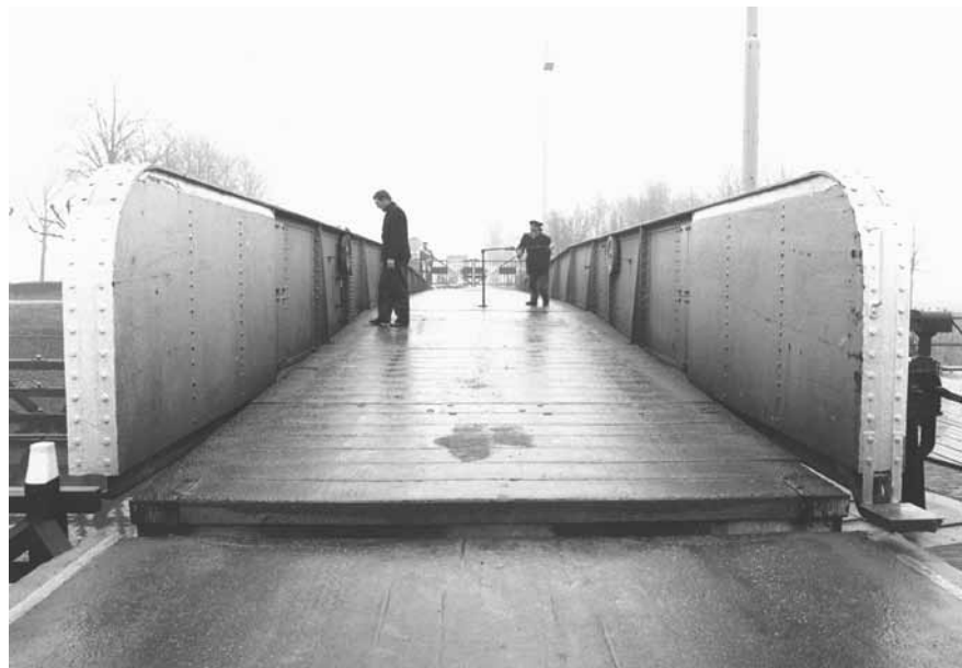
Achteraanzicht van de rolbrug. De sluiswachter links staat voor het bewegings-werk van de koebrug, op de voorgrond is te zien dat de koebrug deels is opgeheven. Aan de hoofdliggers zijn de ballastblokken aan de binnenzijde zichtbaar.
