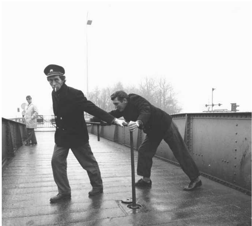
Het openen van de rolbrug is geen sinecure.
