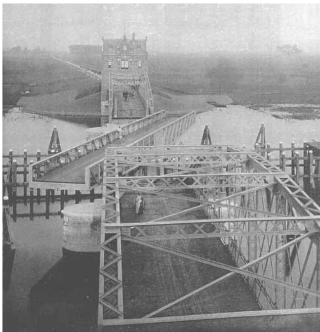
Brug over het Heusdensch Kanaal bij de inbedrijfstelling. Gezien uit het Westelijk Poortgebouw.
