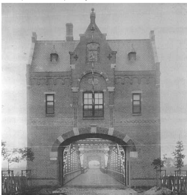
Het oostelijk poortgebouw, september 1896. Te zien is dat de draaibrug smaller is dan de boogbruggen.
