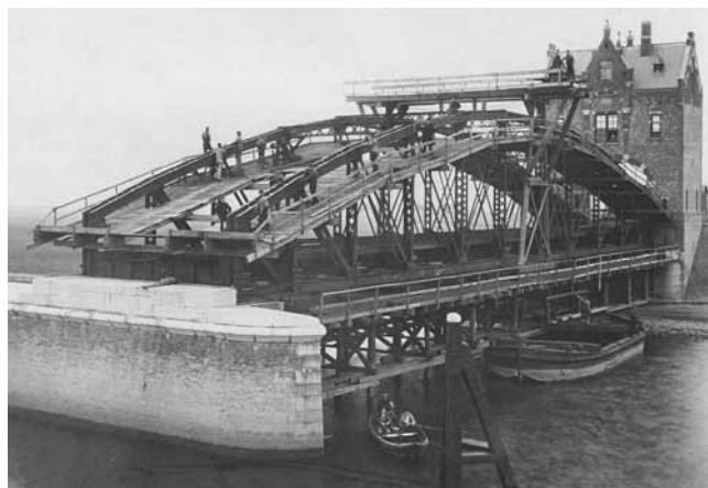
Brug over het Heusdensch Kanaal. De montage van de oostelijke vaste overspanning.
