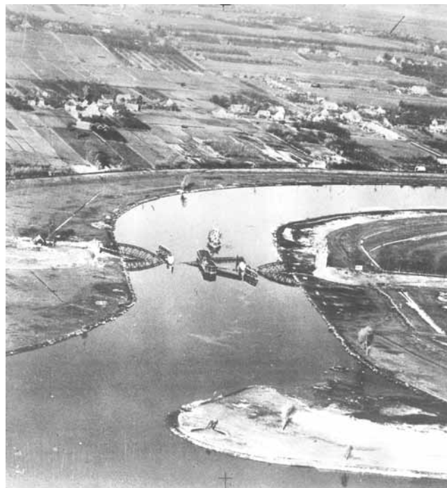
De op 4 december 1944 door de Duitsers opgeblazen brug en westelijk poortgebouw. Op de achtergrond is de aan de grond gelopen en door de geallieerden gebombardeerde Duitse trawler te zien.
