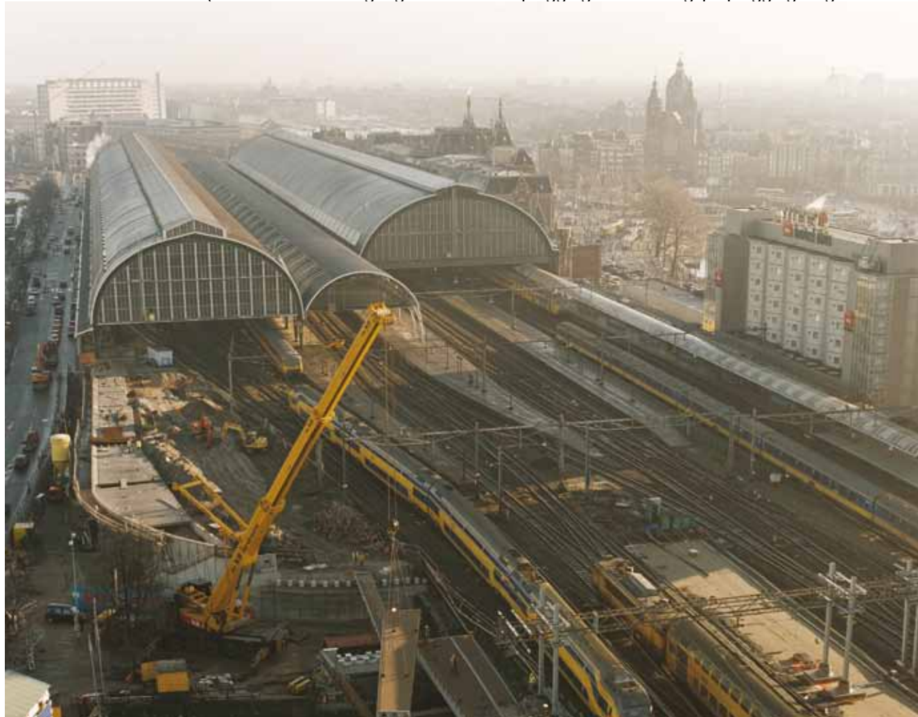
Figuur 4: montage noordelijke verbreding
