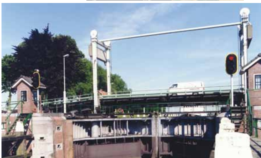
De hefbrug over de Wilhelminasluis. Op de portalen de ballastblokken en omloopwielen van de kabels. De hefkabels zijn aan het linker ballastblok bevestigd, de Demag takel bevindt zich onder de aanbrug. Onder de brug zijn de waaierdeuren van de sluis.
