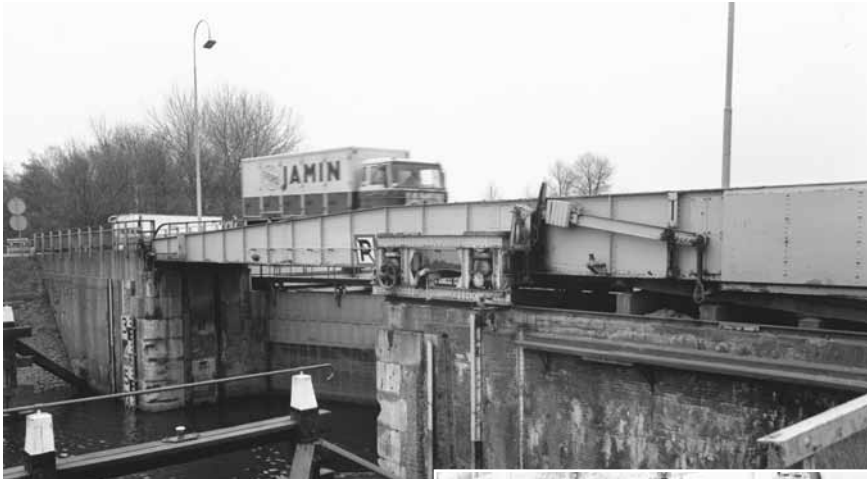
Op de foto is de linker wielkast te zien. Rechts hiervan de hefboom van de balancering van de koebrug. Links van de hefboom de aandrijving en het ballastblok. Op elke hoofdlijger is zo'n voorziening.
