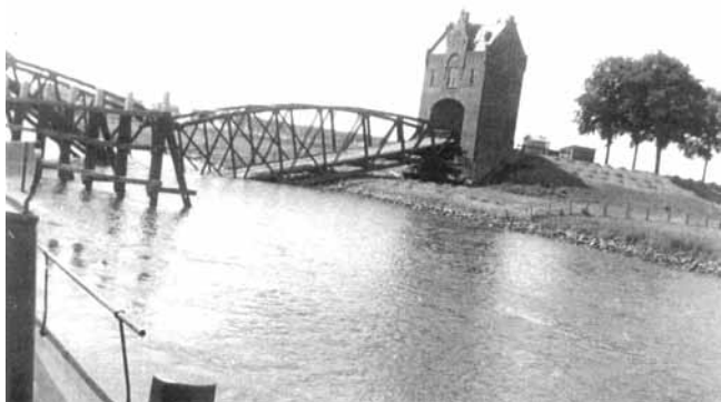
De in de meidagen van 1940 vernielde brug over het Heusdens Kanaal.
