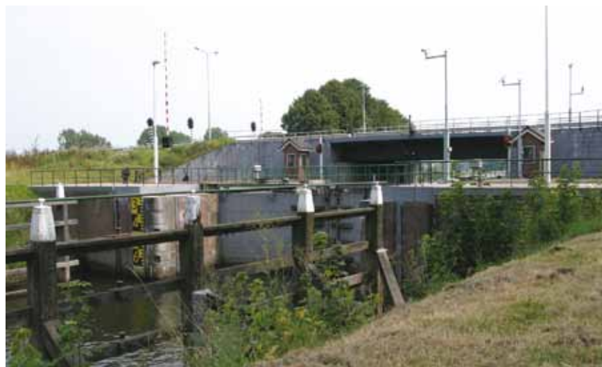
Nieuwe brug over de Wilhelminasluis (foto: Ciska Klooster)
