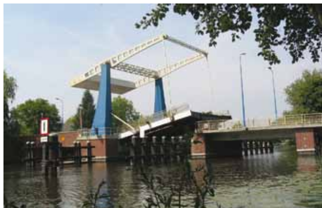
Ophaalbrug over de Vecht bij Vreeland. Foto Holland Railconsult
