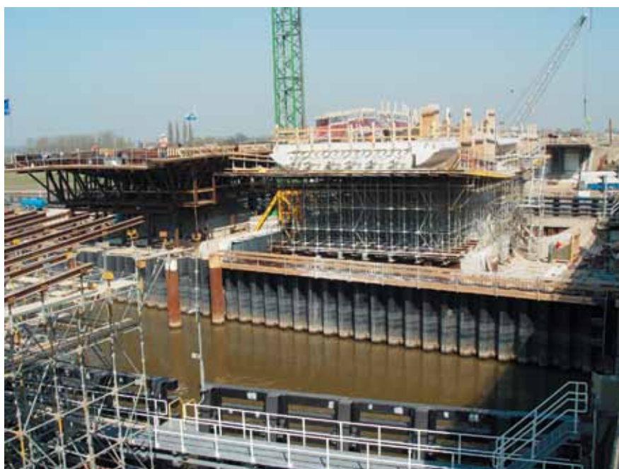
Spoorbrug over het Amsterdam-Rijnkanaal in aanbouw
