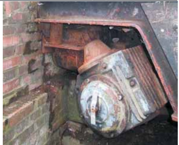
De reductiekast van de gesloopte brug
