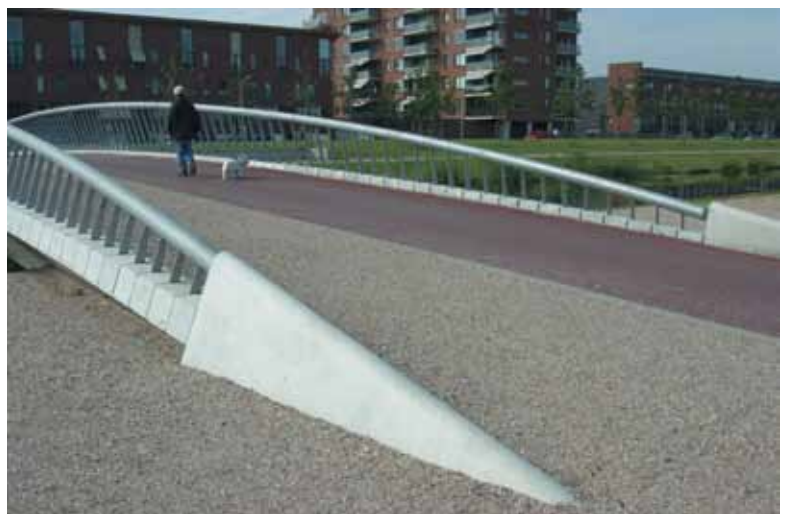
Ypenburg: brug Landingslaan (Foto's: Quist Wintermans Architecten)
