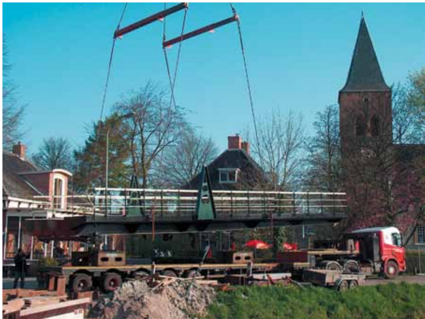
boven: De nieuwe brug wordt van de dieplader gehesen (Foto: S. de Vries)
