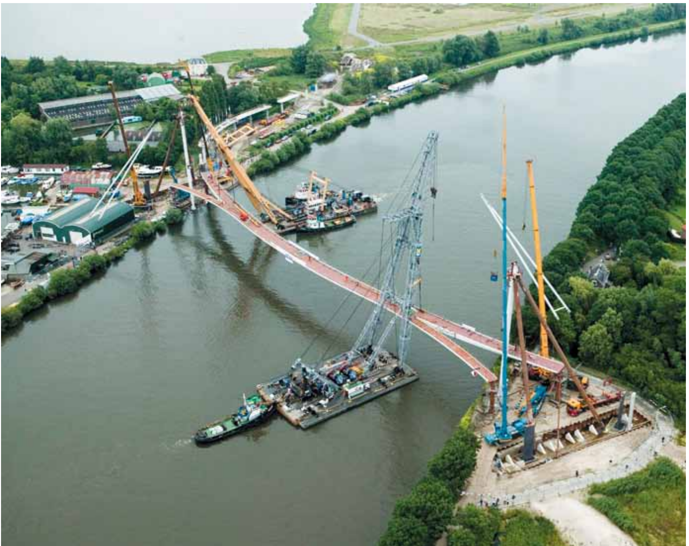
Plaatsing Nesciobrug te Amsterdam
