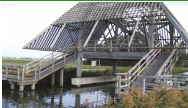
Een robuuste balkconstructie
