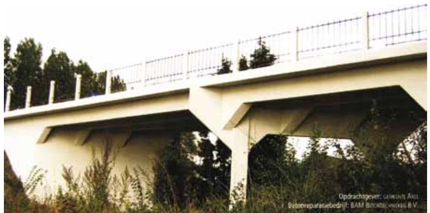
Het viaduct na de renovatie
