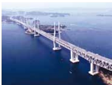
17. Hitsuishijima Bridge, Japan
