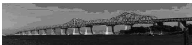
14. Bay Bridge ,cantilever deel, Amerika.
