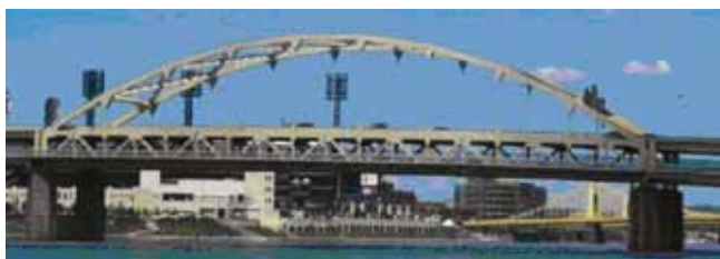
10. Fort duquesne Bridge, Amerika.
