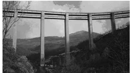
8. Viadotto di Roccaprebalza, Italië.
