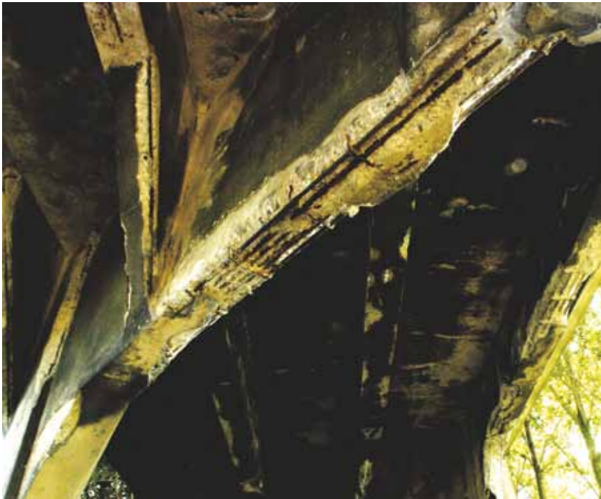
Schade aan het viaduct
