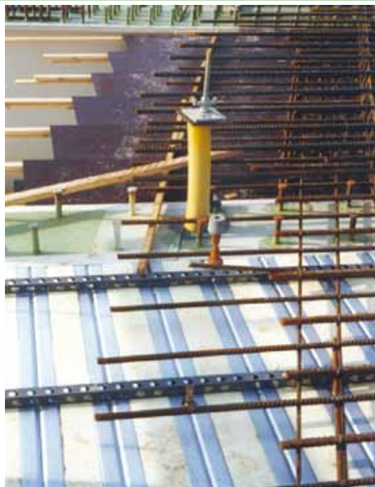
2b. Voorbeeld van aanbrengen van geprofileerde staalplaat als bekisting.
