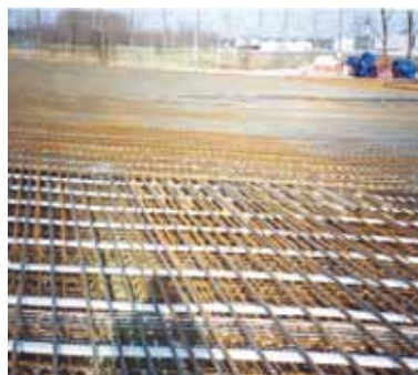
10. Wapeningstaal incl. voorspanwapening rijfvoer staalbeton brug Veghel. (foto midden boven en links)
