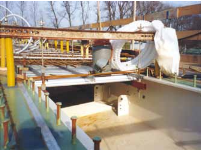
2a. Voorbeeld van aanbrengen van geprofileerde staalplaat als bekisting.
