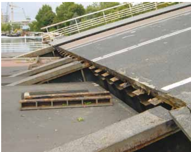
Aanvang sloop van houten dek
