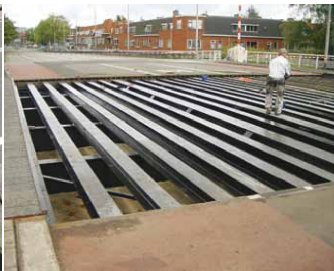
Conservering van de langsliggers
