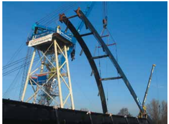
Booghelft zijde Deventer hangt boven de aansluitingen op rijvloer.
