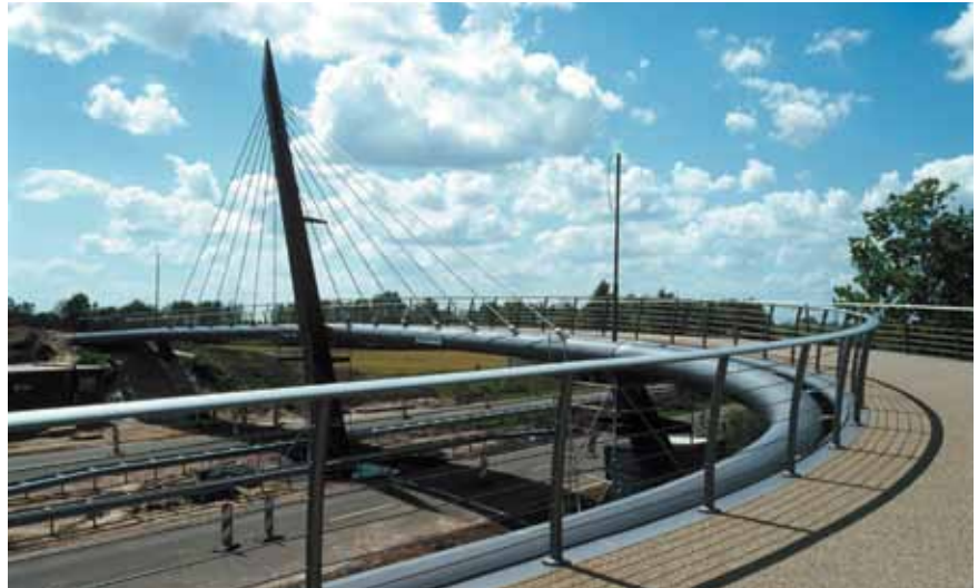
Pyloonbrug in Emmen in aanbouw. (foto: IPV Delft)
