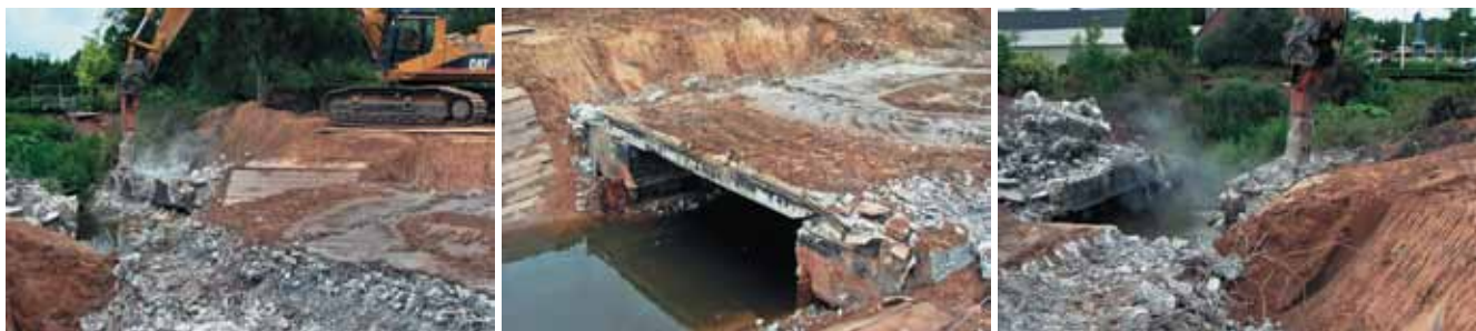
1. Sloop van de bestaande brug
