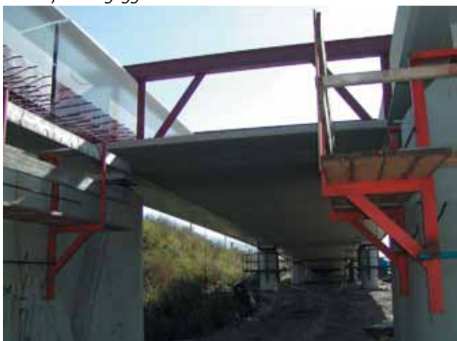
5. Hulpconstructie en prefab platen.
