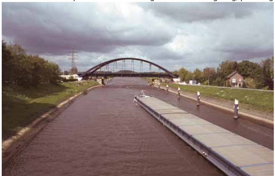
Spoorbrug over het Twentekanaal (foto: Martin Uitvlugt)
