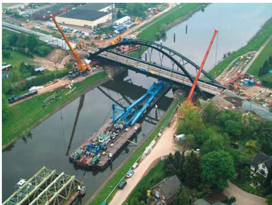
Spoorbrug bij Eefde in aanbouw. (Foto: Holland Railconsult)
