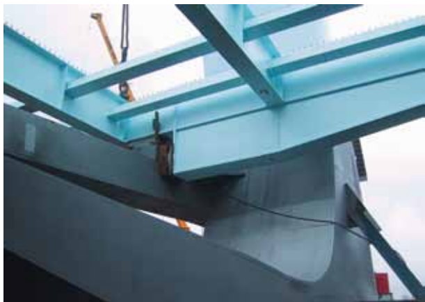
4. Afstempeling van de rijvloer tegen de pyloon.
