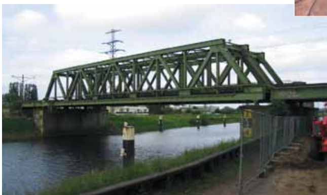
Overzicht oude overbrugging vanaf de noord-oostzijde richting de westzijde.
