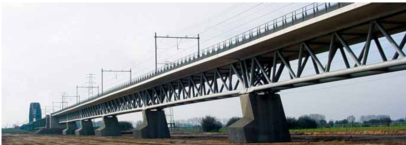
Aanzicht van de nieuwe aanbruggen.
