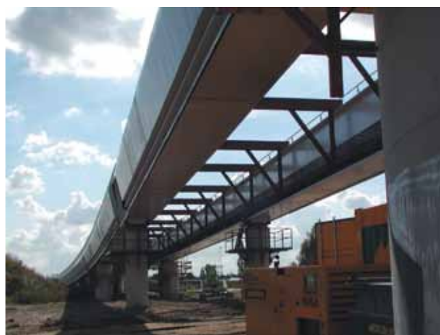
4. Fixeren hoofdlijggers door tussengelegen hulpconstructie
