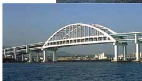
12. Rokko Island Bridge, Japan.
