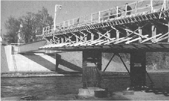
3b. Wijze van aanbrengen van bekisting via onderflens stalen ligger.
