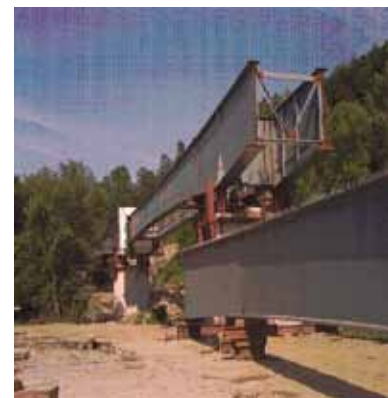
11. Staalbeton plaatliggerbrug met hooggelegen rijvloer.
