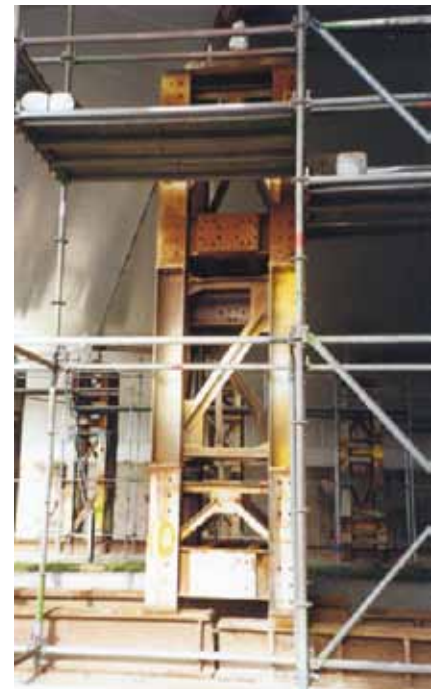
17. Geschematiseerde weergave van een hulpsteunpunt.
