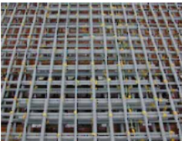
1. Voorbeeld van wapening rijvloer uitgevoerd in VVK.
