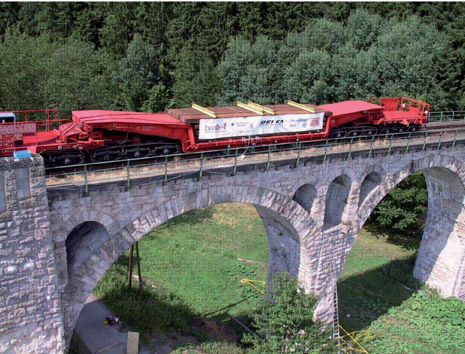
9. BELFA in test positie (op een kwart van de overspanning; zwakste schakel van de boogconstructie).
