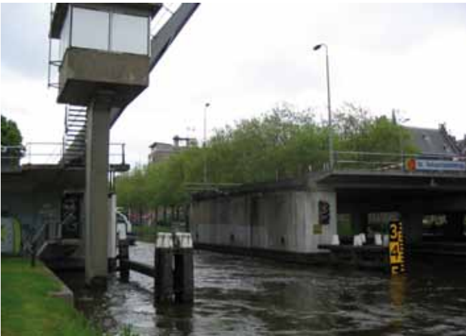
8a. Basculebrug in geopende stand
