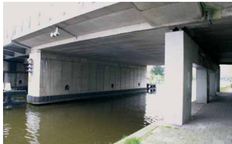
10. Vaste overspanning aanbrug boven vaarweg (provincie Zuid-Holland)
