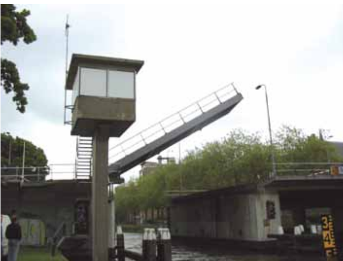
8b. Basculebrug in gedeeltelijk geopende stand
