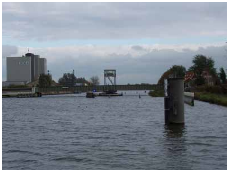
De oude draaibrug Stroobos in oostelijke richting gezien
