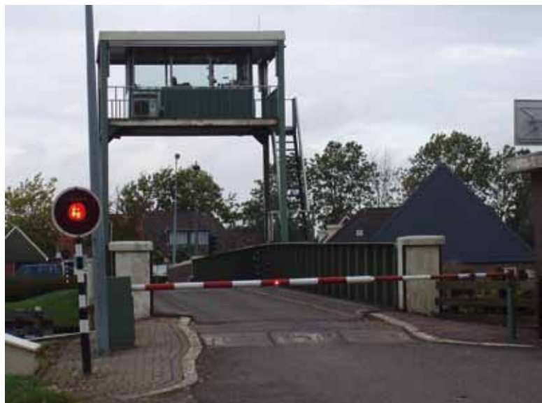
De oude draaibrug met eigen bedieningspost boven de brug
