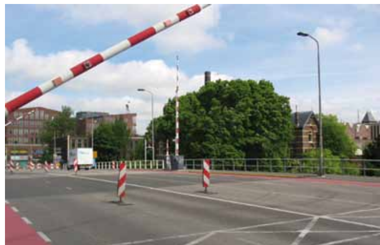
11a. Huidige situatie op het brugdek
