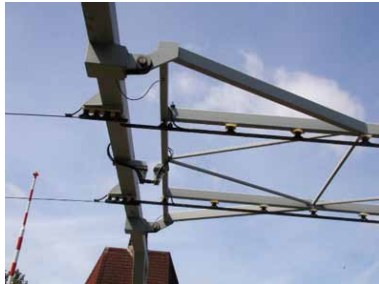
9. Voorbeeld detail meebewegende bovenleiding draagconstructie
