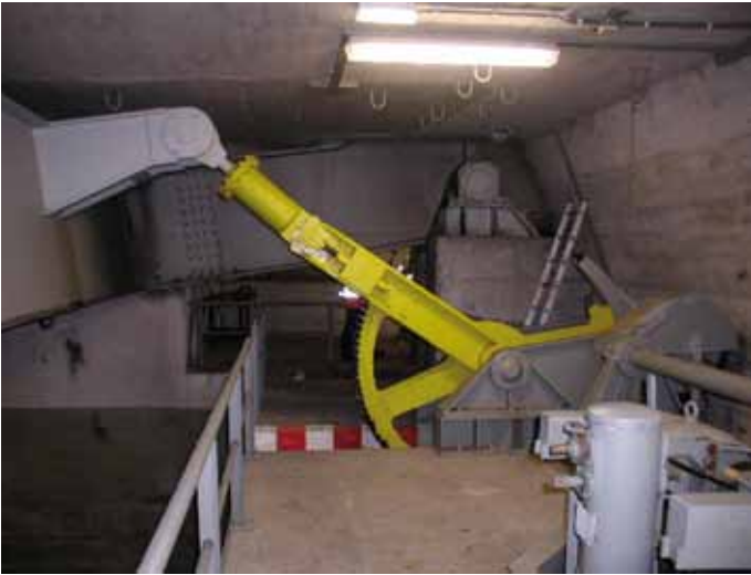
7. Bewegingswerk in basculekelder
