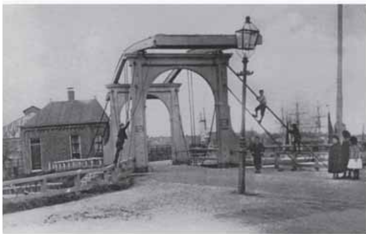
14. Brug over de 'Marine Schutsluis' uit 1847. Opname 1900
