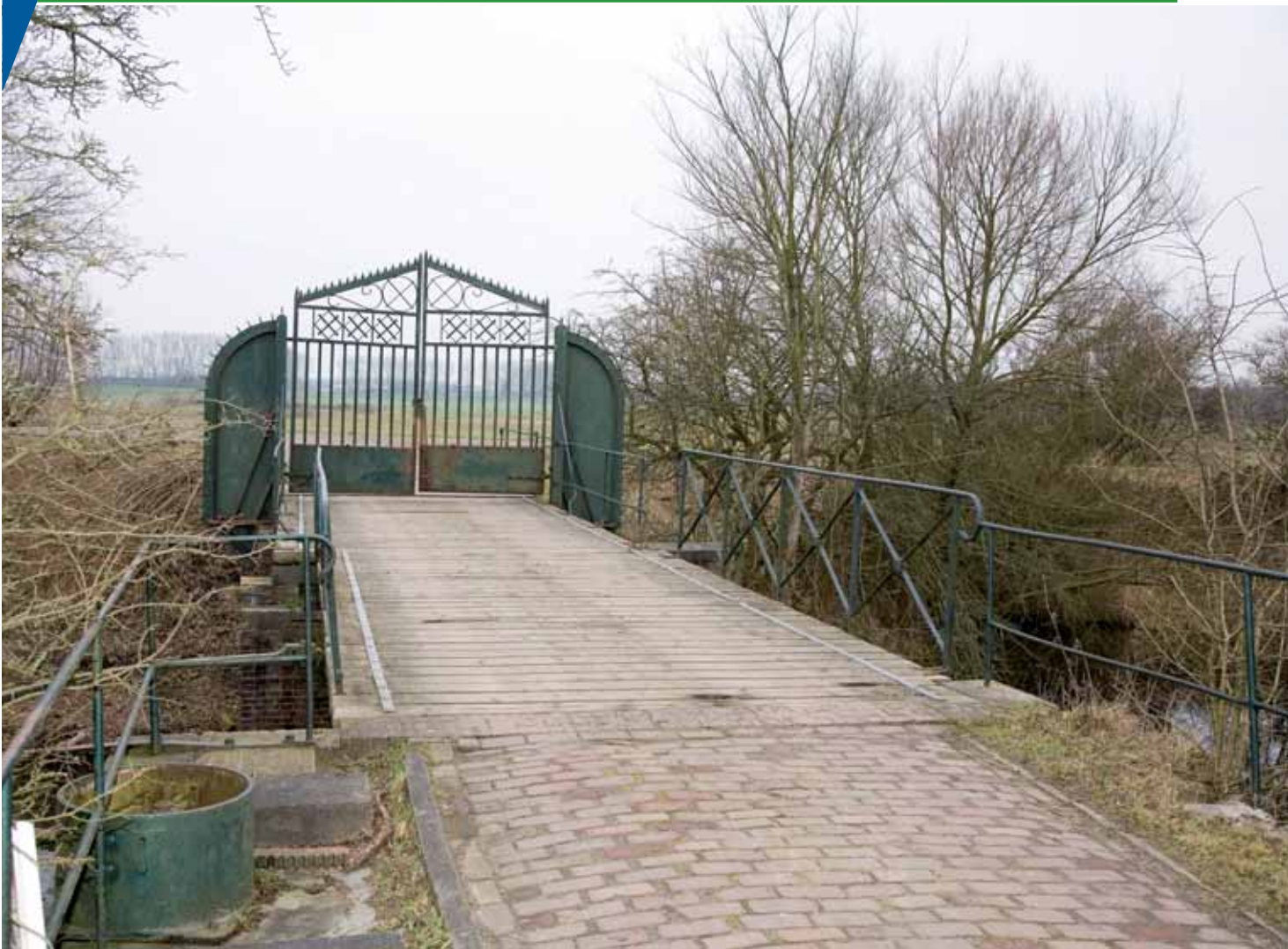
De brug gezien vanuit het oosten. Op de voorgrond de kraanbrug, erachter het vaste deel van de brug met het afsluithek, 2005.
