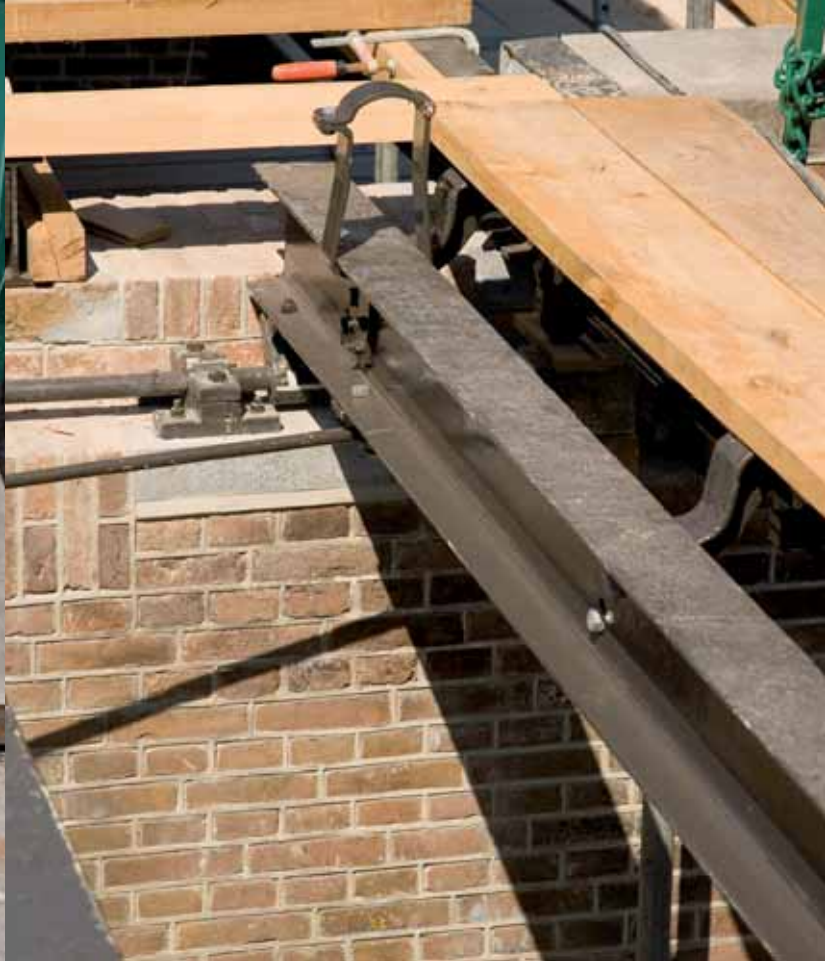
Op linkerpagina: foto's van de voltooide restauratie Boven (links): Het wegdek kan worden weggenomen zodat de brug weer kan worden gedraaid. Boven (rechts): Detail van brugligger en wegdek
