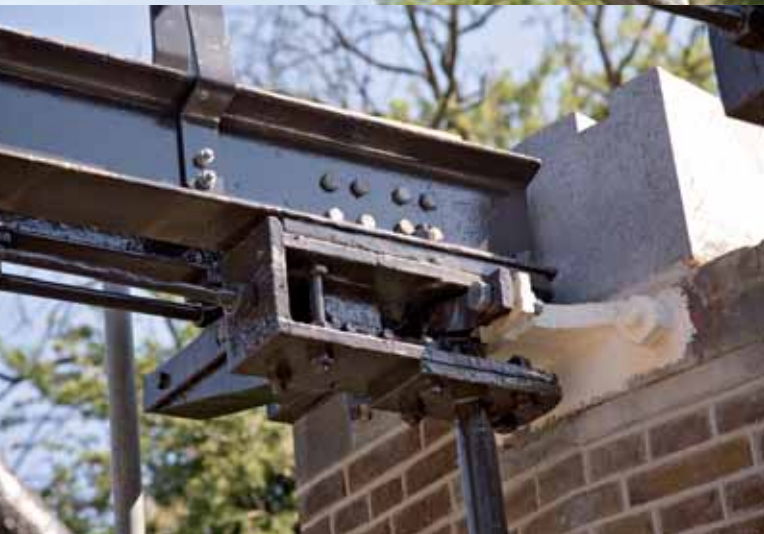
Linksonder: Detail van bovendraaipunt van de kraanligger.
