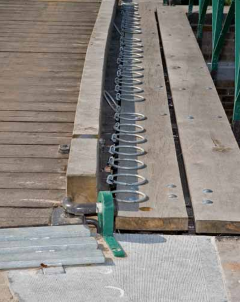
Op linkerpagina: foto's van de voltooide restauratie Boven (links): Het wegdek kan worden weggenomen zodat de brug weer kan worden gedraaid. Boven (rechts): Detail van brugligger en wegdek
