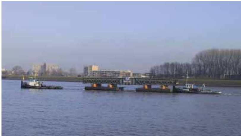
Transport oude Haarbrug op pontons naar Rotterdam
