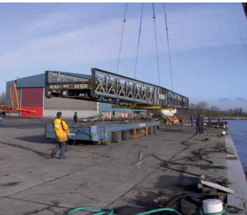
De draaibrug wordt op een vrachtwagen gehesen.
