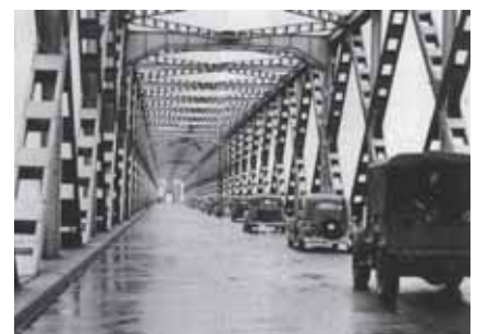
Boven: Hergebruikt gedeelte van de Moerdijkbrug in Spijkenisse Daaronder: De Moerdijkbrug van vóór de Tweede Wereldoorlog Onder: De Sint Servaasbrug in Maastricht
