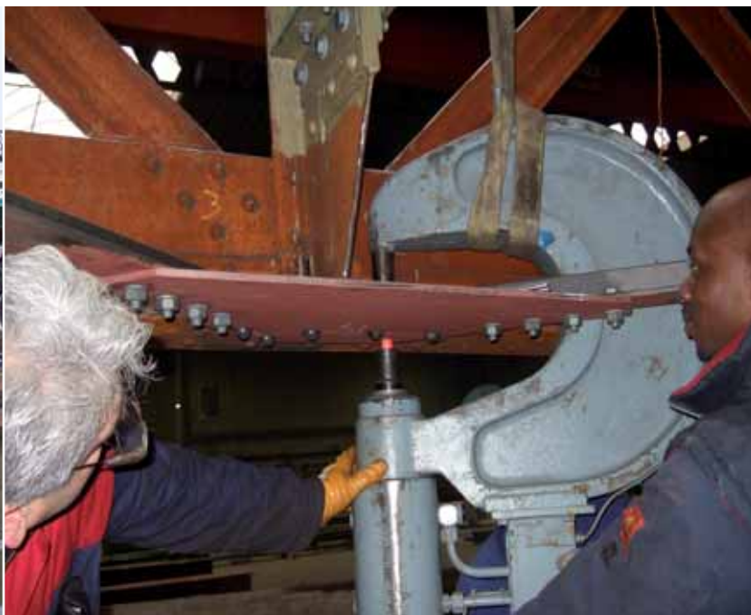
afb. 5 Klinken met de hydraulische pers (foto ing. J. Den Toom)
