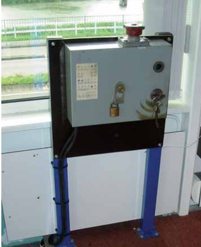
links: sleutelvergrendelkast rechtsboven: veiligheids PLC rechtsonder: geautomatiseerde bediening
