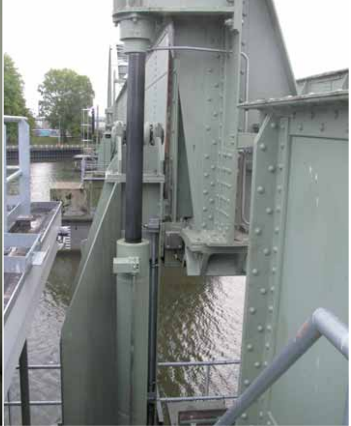
linksboven: detail mechanische gelijkloop linksonder: spoorstaaf overgang brug bijna gesloten rechts: opstelling primaire cilinder (zijde Lanaken)
