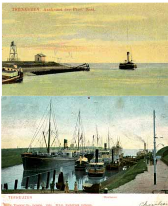
Boven: De oude aanlegplaats aan de Westpier. Onder: De oude aanlegplaats aan de westzijde van Bastion I.
