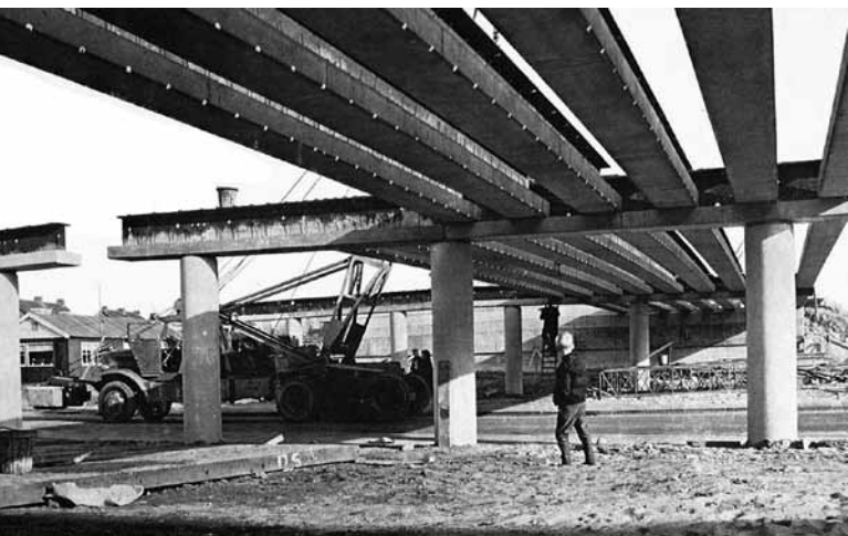
Principe-doorsnede Preflexligger en een eerste toepassing van Preflex pijlerbalk en Preflex langsliggers
