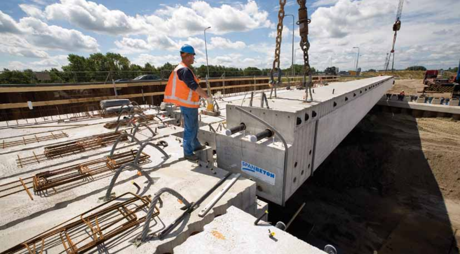
Het 4P systeem bij de brug over de toekomstige omlegging van de Zuid-Willemsvaart
