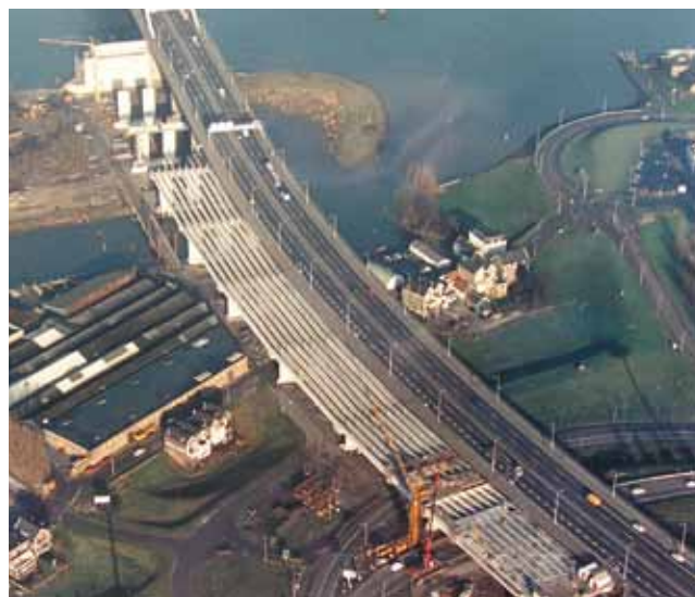
Liggers aanbrug voor de tweede Van Brienoordbrug
