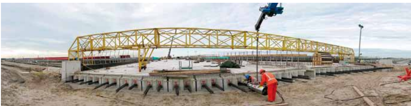
Het 3P systeem bij viaduct Lage Weide
