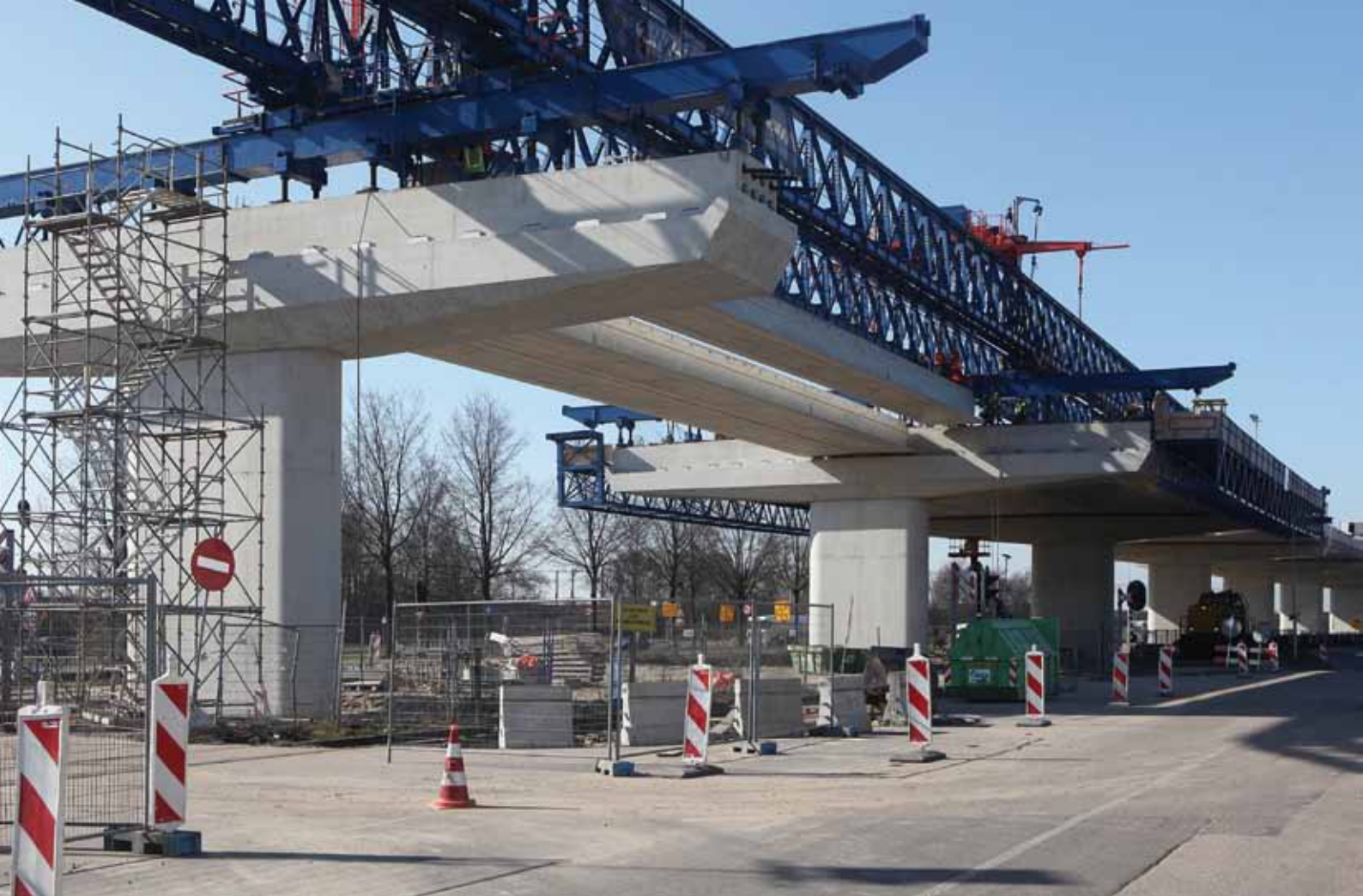
6. Monteren betonnen liggers Westrandweg boven Basisweg met lanceerligger Hercules, Amsterdam foto: Rinze Heida / Van Hattum en Blankevoort
