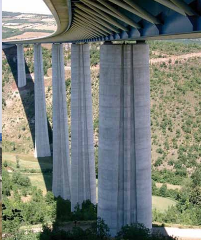
5. Viaduc de Verrières in staal-beton over een 180 m diep dal, foto: Jaques Mossot ( www.structurae.com )
