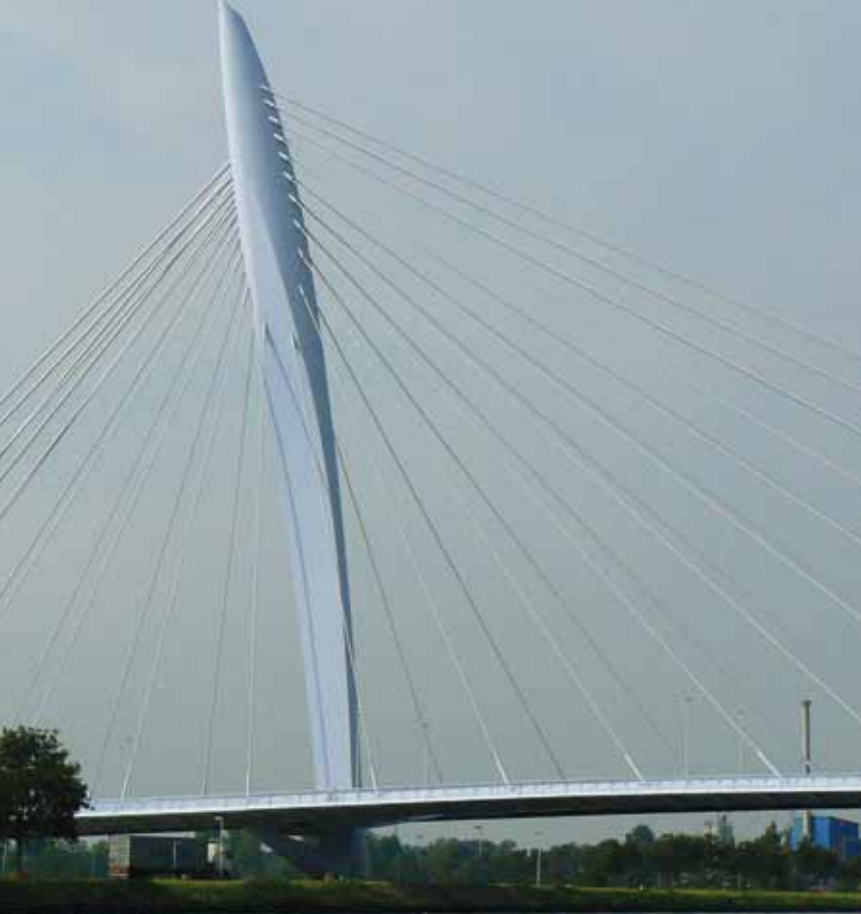
7. Prins Clausbrug, staal-beton tuibrug over het Amsterdam-Rijnkanaal, Utrecht, foto: Jan Carel van Eijk
