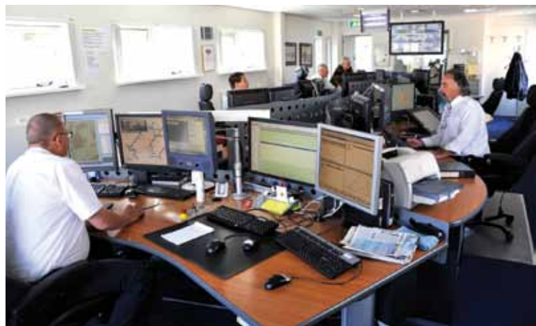
7. Afstandsbediening van sluis en bruggen in het Rijn-Schiekanaal te Leidschendam
