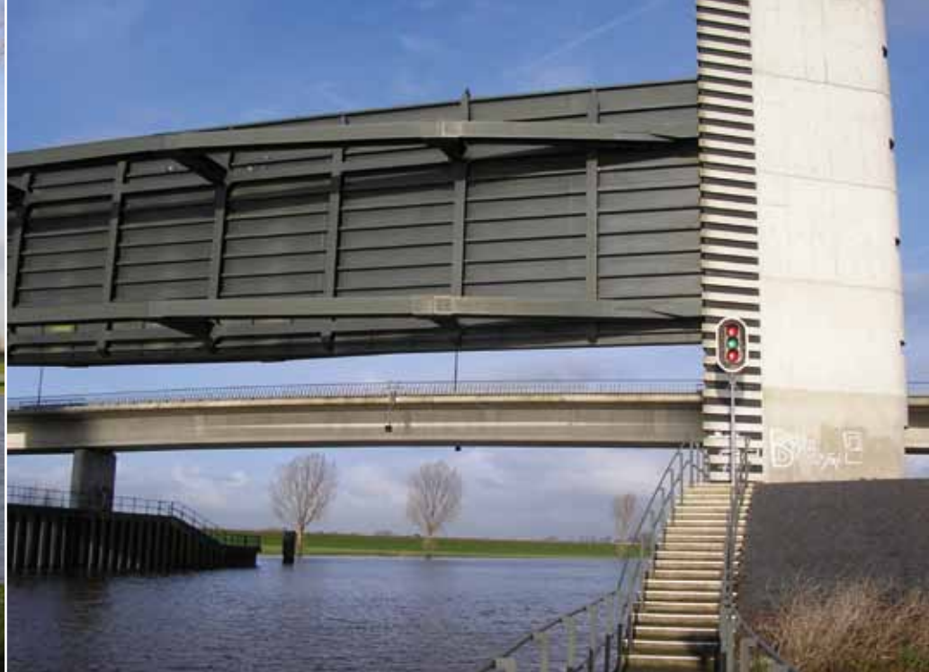
Afb. 1 Draaibrug Geertruidenberg, afb. 2. Tuibrug bij Heusden, Afb. 4. Kromme Nolkering in Heusden, inzet Afb. 3. Gedenkteken oude brug bij Heusden
