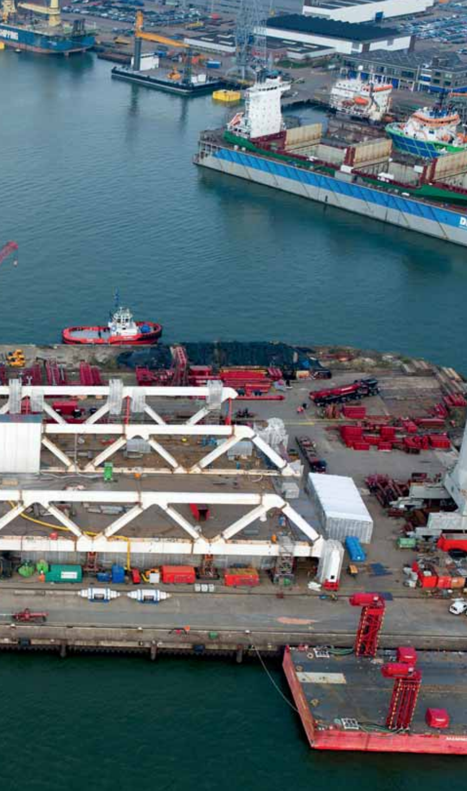
2 Stalen eindstuk contragewicht met trekstangen
