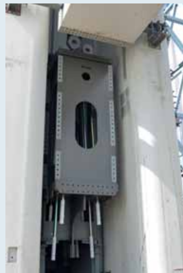
2 Stalen eindstuk contragewicht met trekstangen
