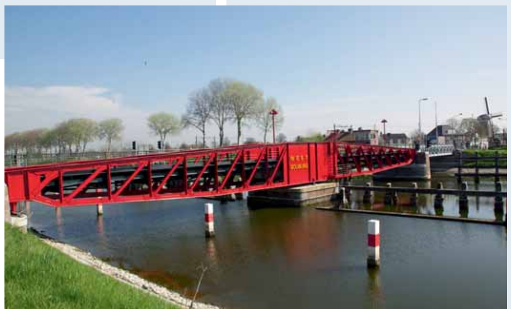
5 de gerenoveerde brug gereed
