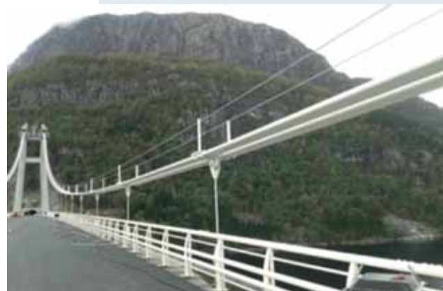
↑ Afbreken van de catwalk
