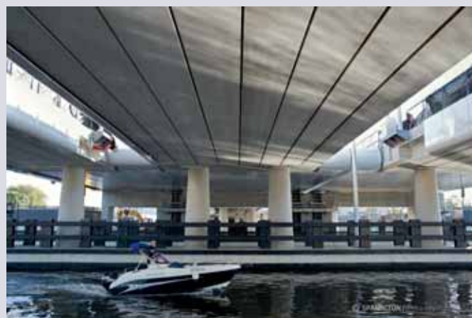
Onderaanzicht en lijnenspel van de prefab brugdekken
