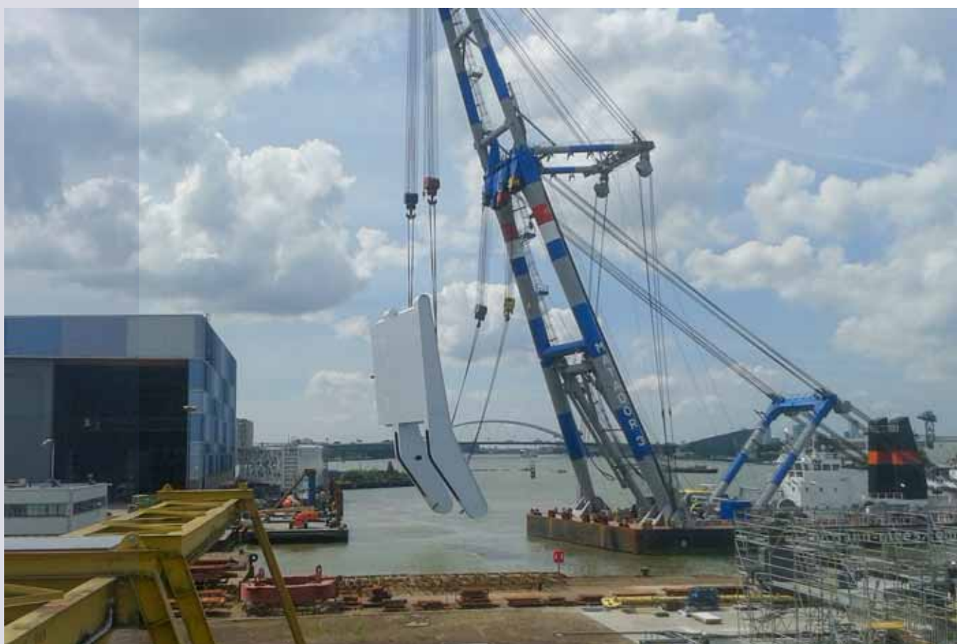
Plaatsen val op ponton
