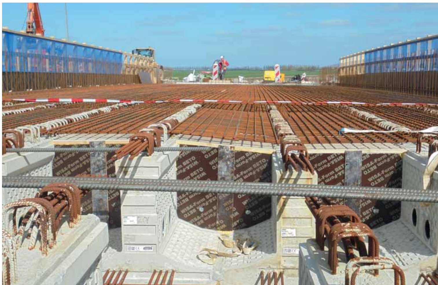
Liggerhoogtesprong in de dwarsdoorsnede van het dek
