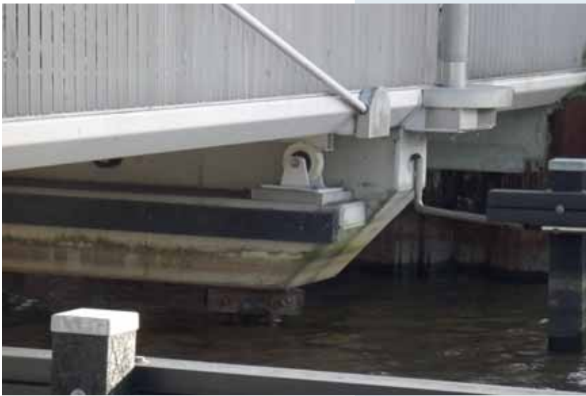
↑ Oplooptiel ter plaatse van landhoofd met olopblok
