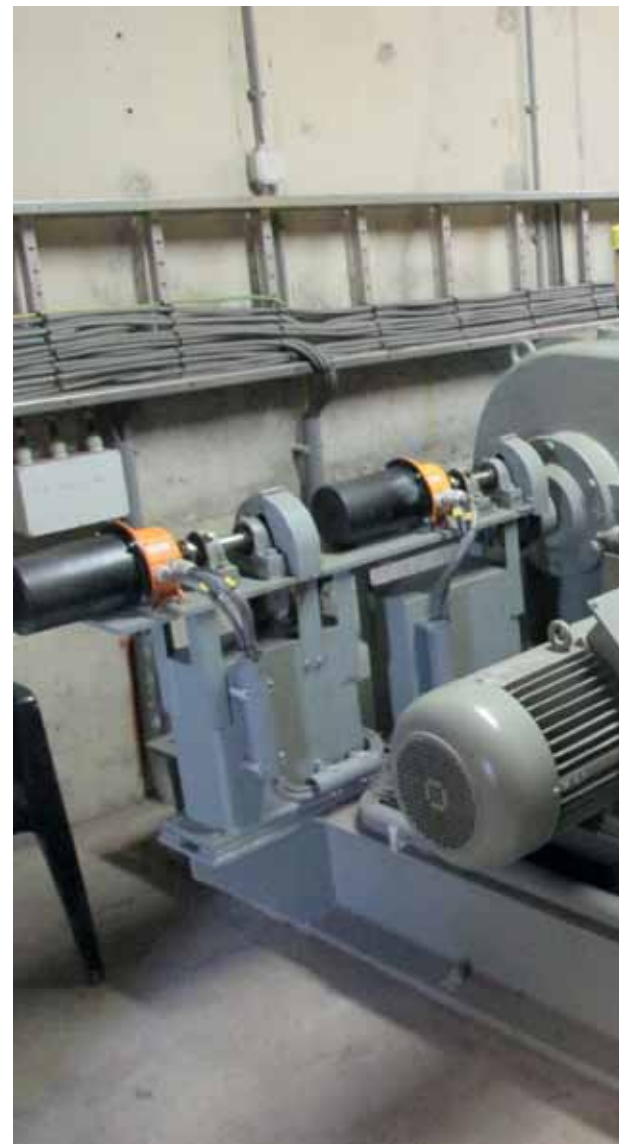
↑ Figuur 4 en 5 ↘ Het bewegingswerk van de Aardammerbrug, een panamakruksysteem, het origineel stamt uit 1977. Rechts de situatie na het geplande groot onderhoud in 2016/2017. Vrijwel het gehele bewegingswerk blijft behouden (© Movares)
