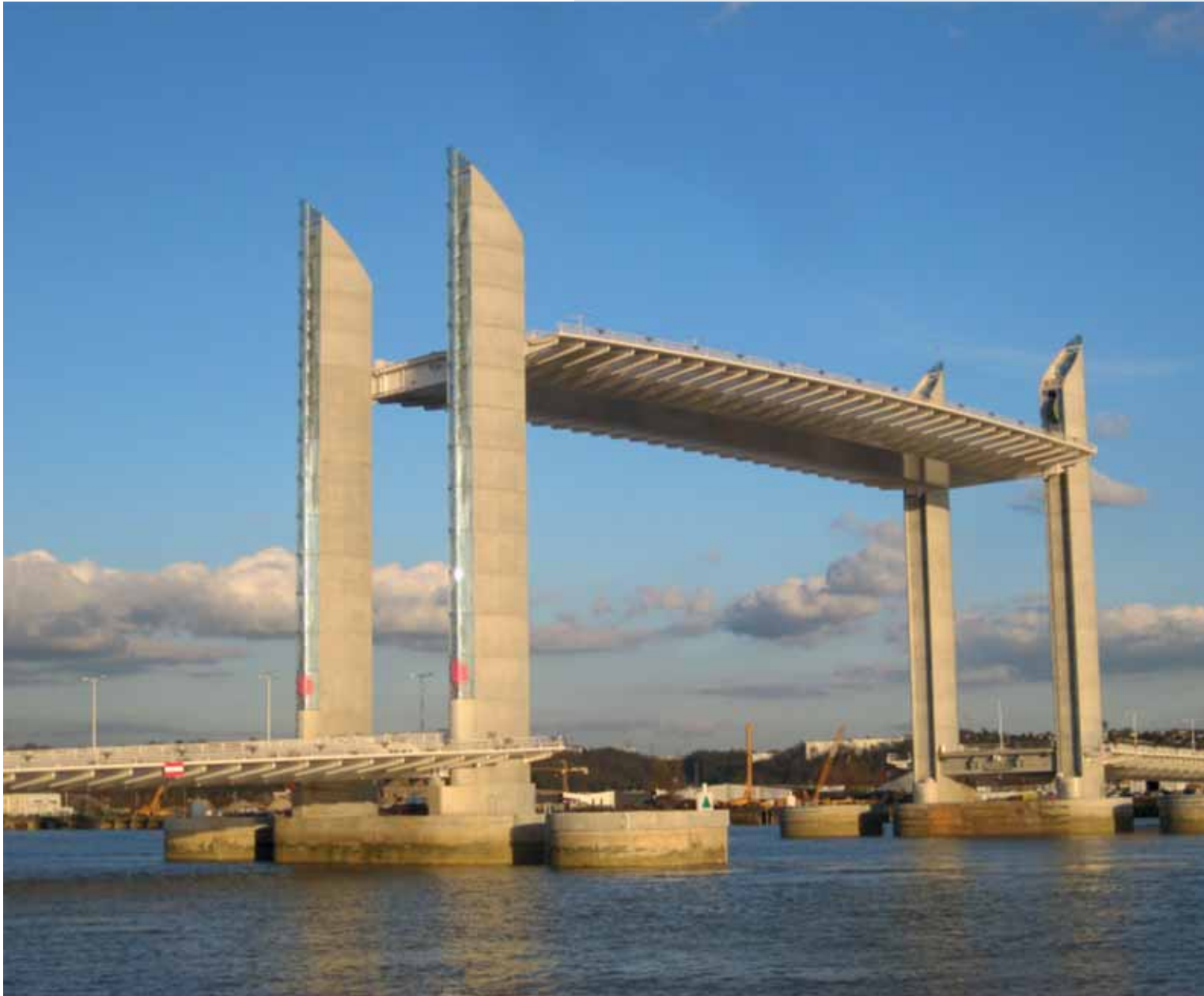
↑ Chaban-Delmas brug, Bordeaux (doorvaartbreedte 106 m, hoogte 53 m)
