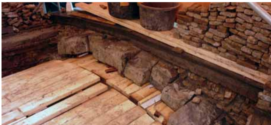
← Houten formeel voor het opnieuw opmetselen van het gewelf van de Vrouwe van Rijnsburgerbrug (bron: Van der Ven).
