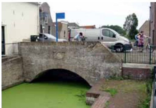
↑ Gerestaureerd buitenfront van de Havensluisbrug met dateringssteen 1704.
