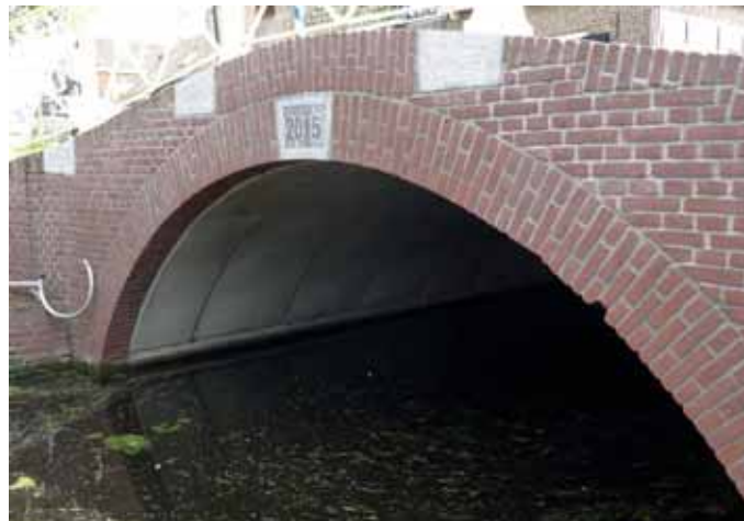
↑ Onderzijde betonnen gewelf.
