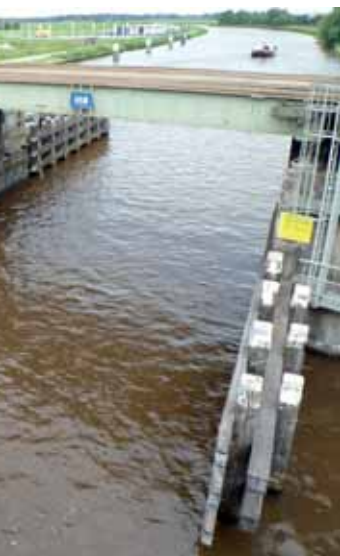
↑ Brug HRM103°. Foto: © Movares
