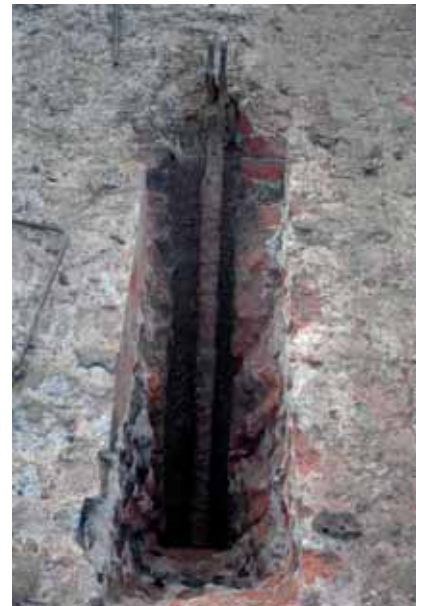
↑ De historische ankerstaaf is omwikkeld met in bitumen geïmpregneerde stof.
