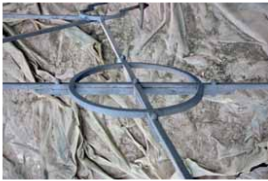
↑→ Verbindingsdetails van de smeedijzeren leuning worden zichtbaar na stralen
