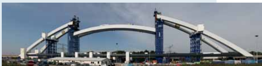
↑ Assemblage van de brug (inbrengen middendeel boogsectie met strand-jacks)
