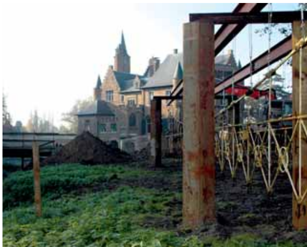
↑ De historische brug wordt naar de oever verplaatst.
