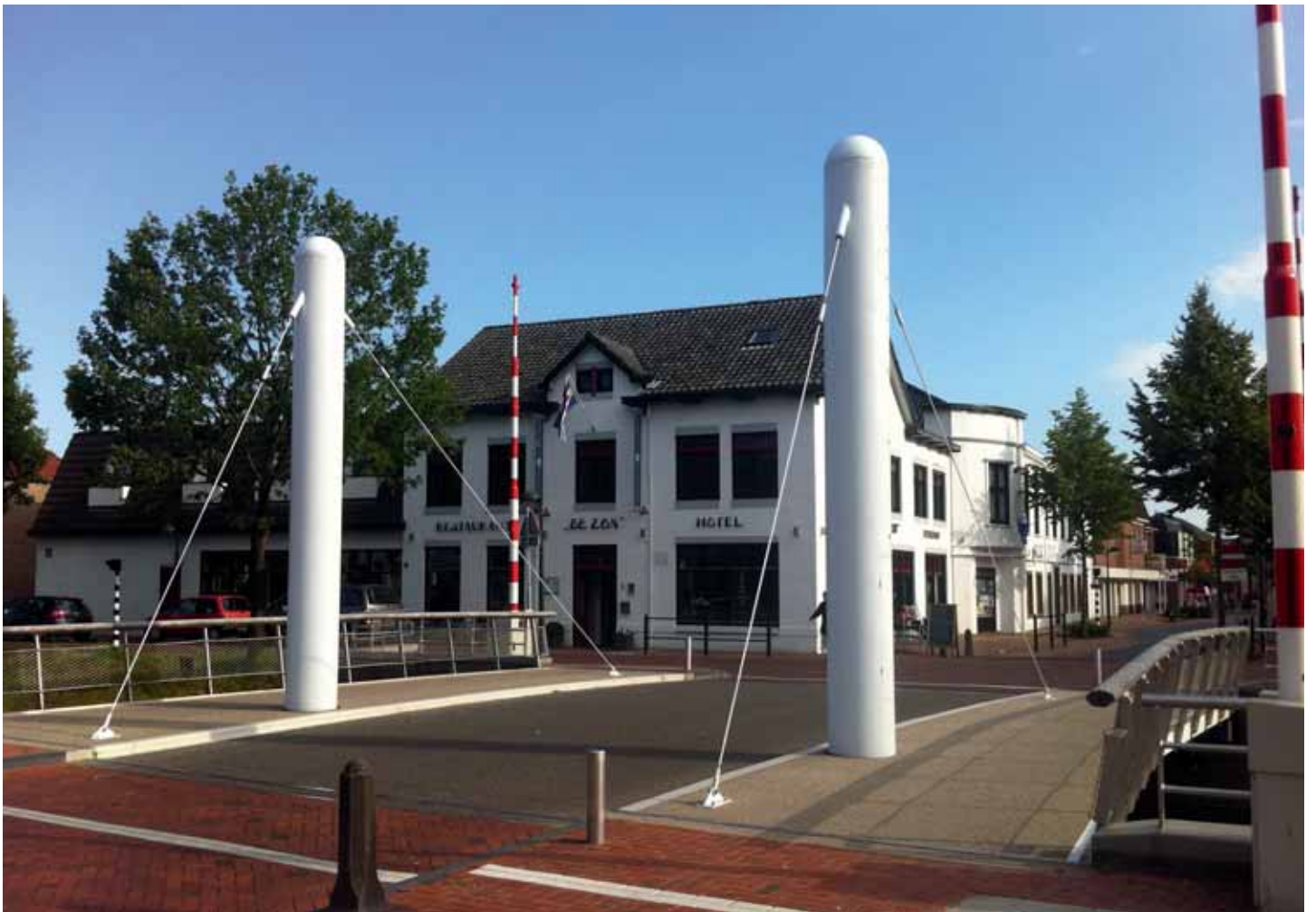
5 Hefbrug Oosterwolde – het contragewicht zit in de korte zijde van het dek producent VVK: FiberCore Europe
