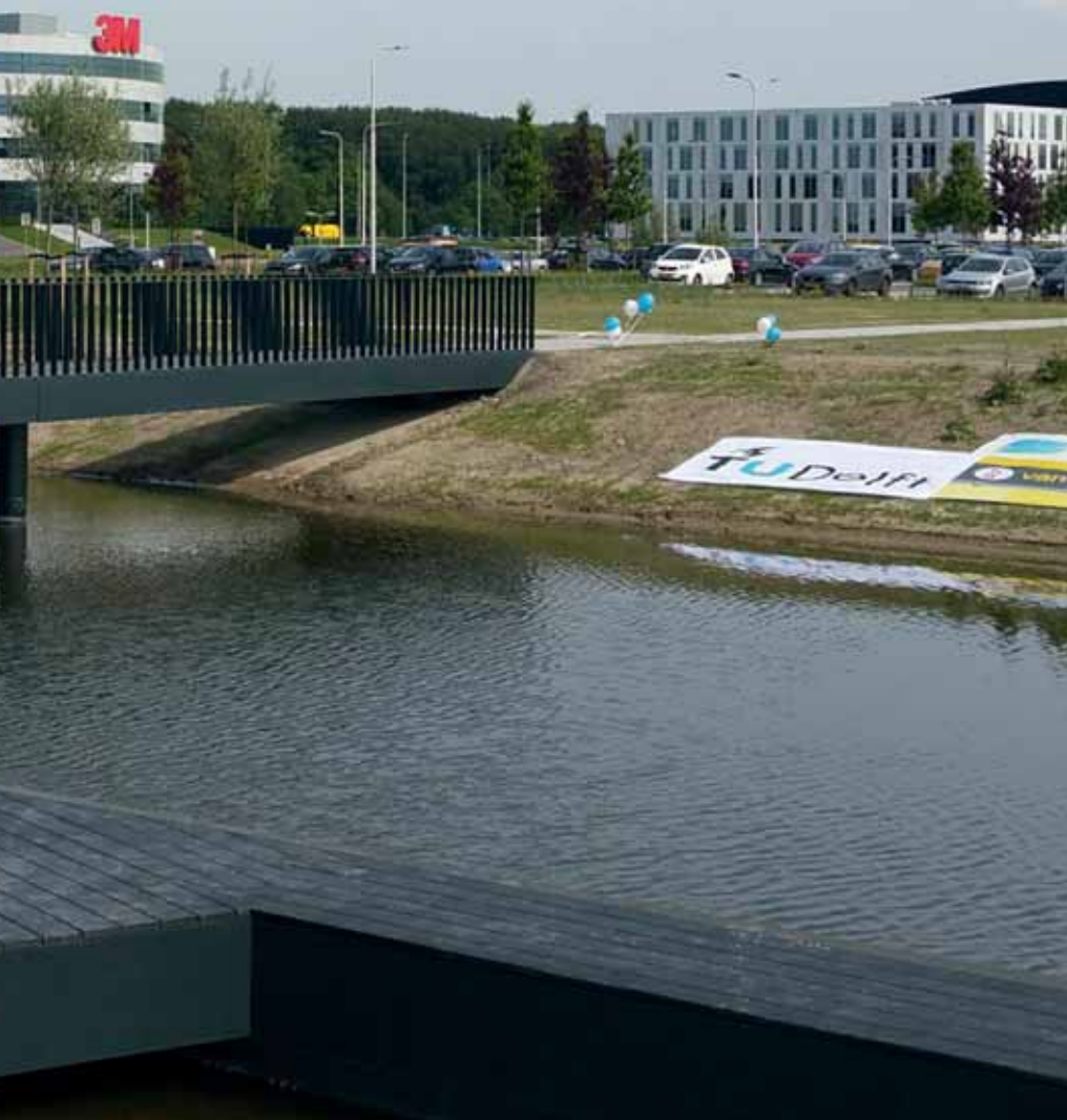
1 'Smart' bridges: communicerende, zich zelf monitorende bruggen (producent MOCS)
