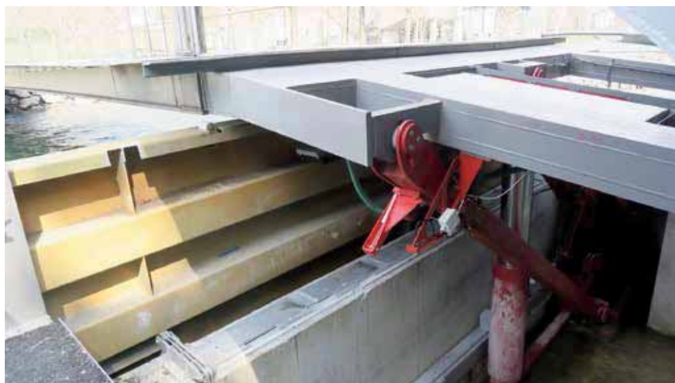
Detail van het afdichtingsschot op linkeroever
