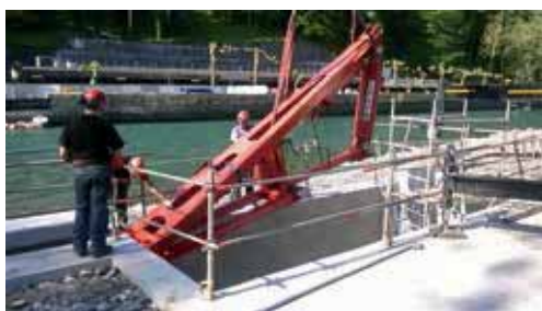
Het hefsysteem bij plaatsing op de bouwplaats
