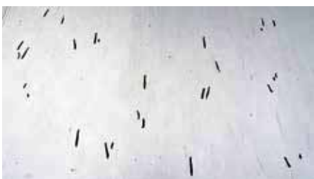
Aangebrachte perforaties in het brugdek
