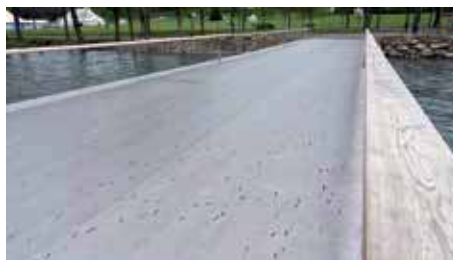
Zicht op het brugdek
