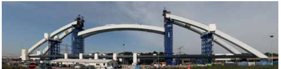
4 Assemblage van de brug (inbrengen middendeel boogsectie met strand-vijzels)
