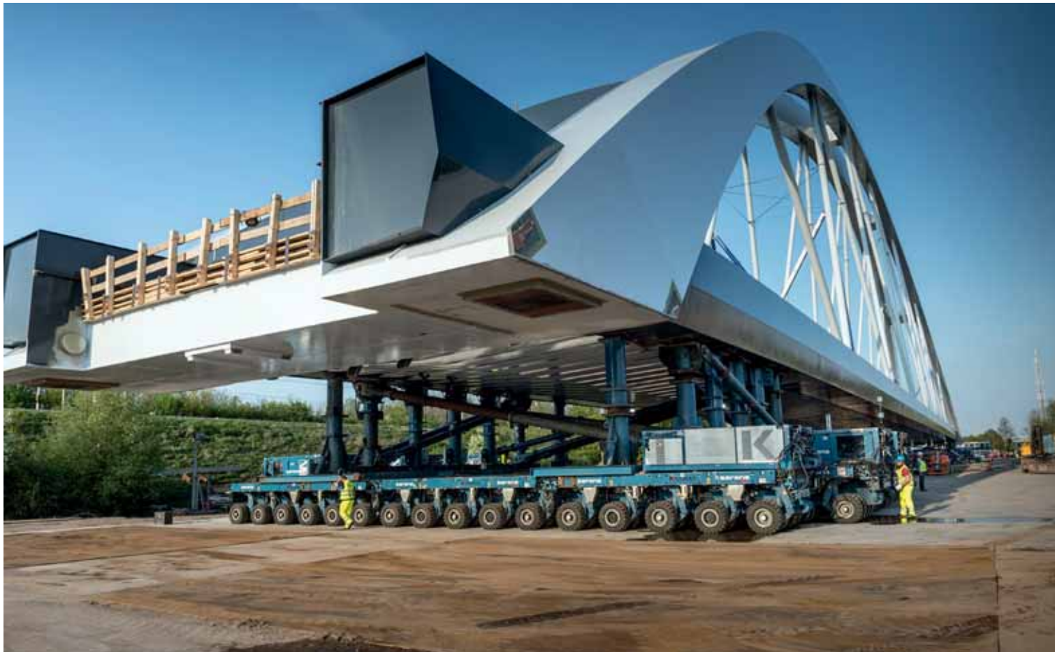
13 Transport over de A1 met behulp van een SPMT (mei 2016)
