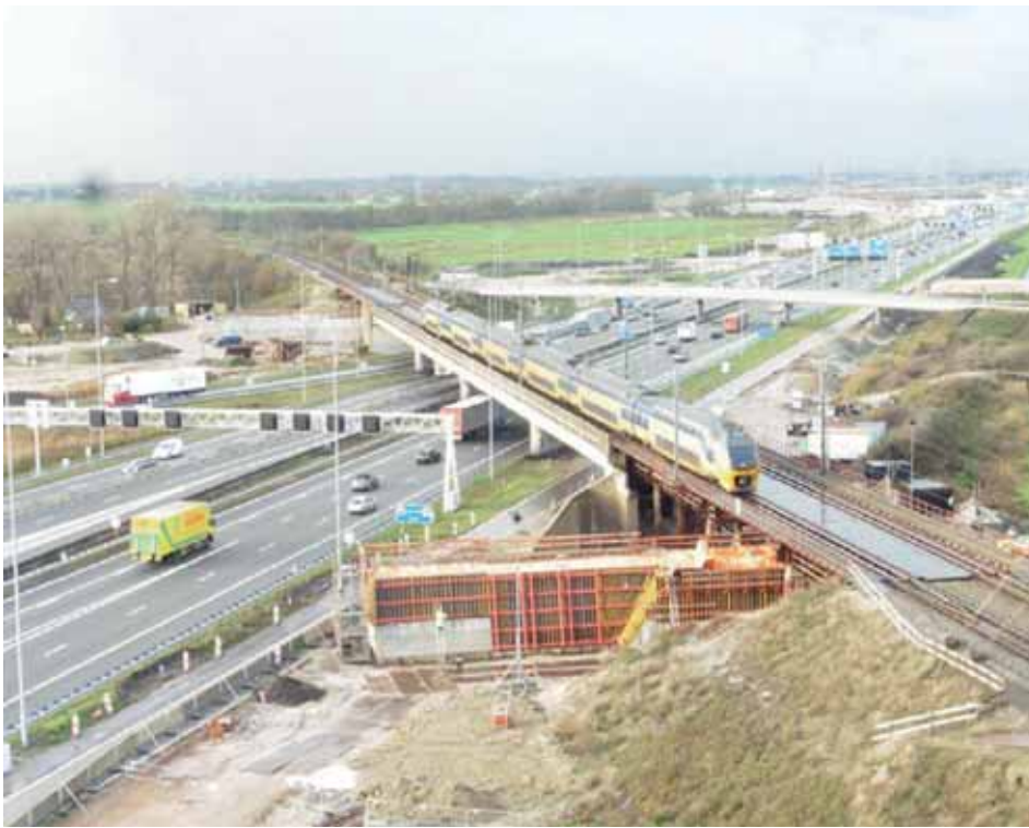
3 Bouw van één van de tijdelijke landhoofden
