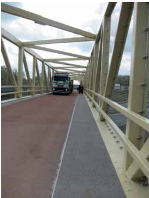
3 Hybride brug Lunetten voor voetgangers en autoverkeer 140 m lang en 6,2 m breed
