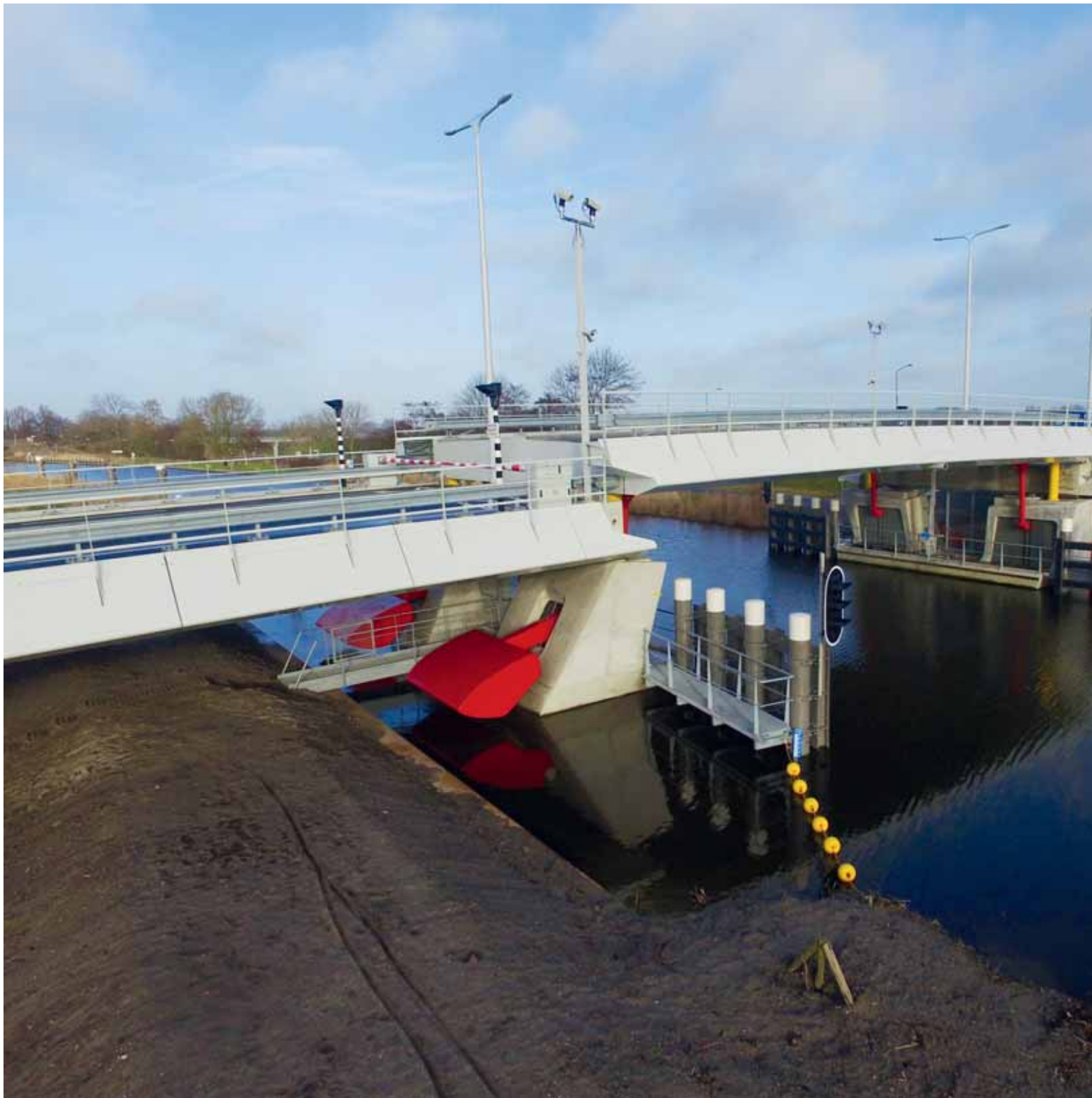
9 Nelson Mandelabrug, Alkmaar; tafelbrug (hefbrug met geringe hefhoogte – hier ongeveer 1,5 m) producent VVK: Delft Infra Composites
