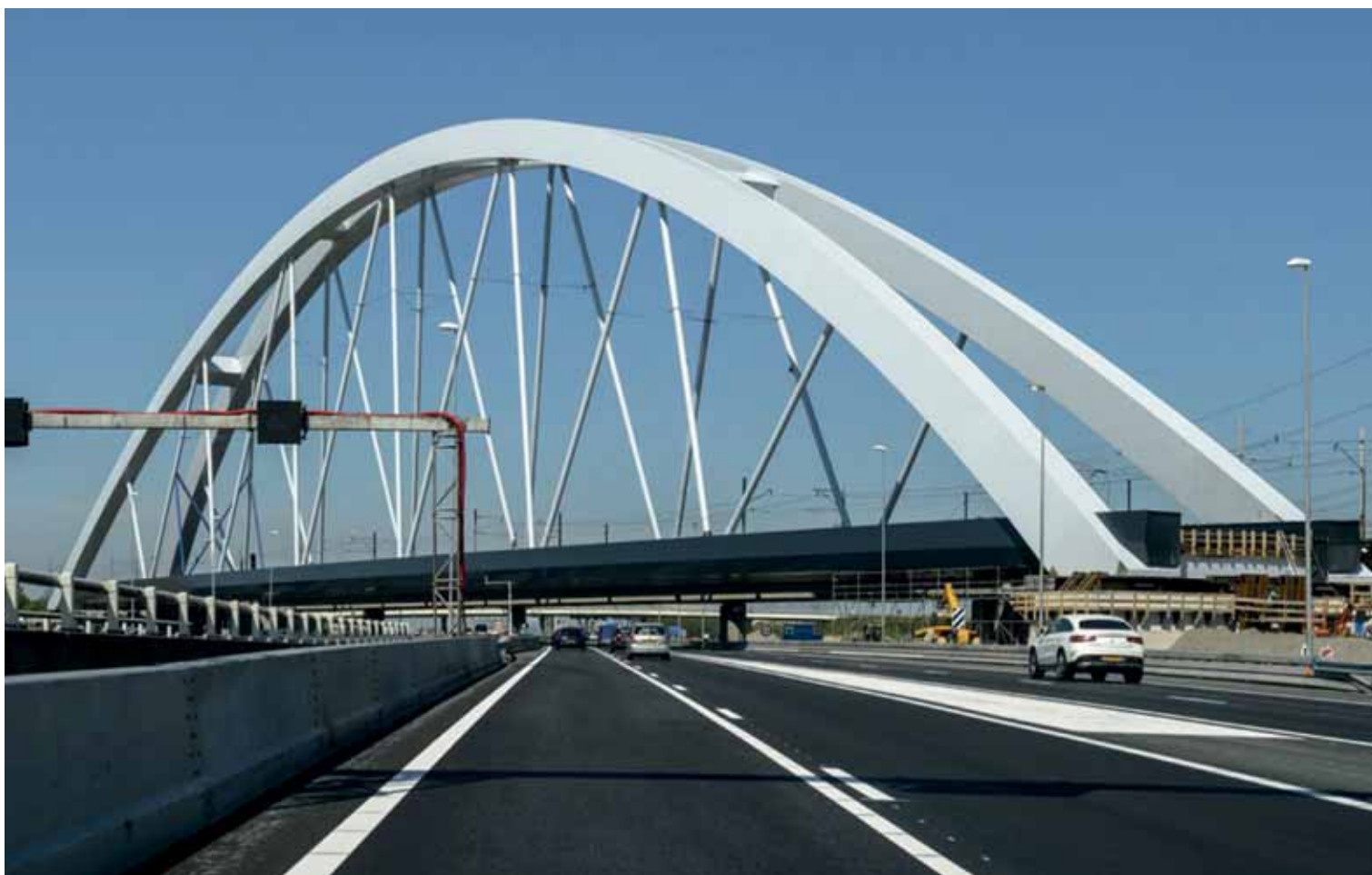
14 Afwerken brug boven de A1 (juni 2016)
