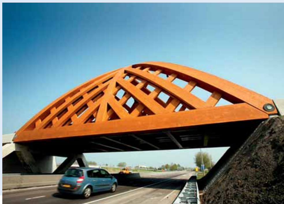
Viaduct van accoya-hout (Sneek).
