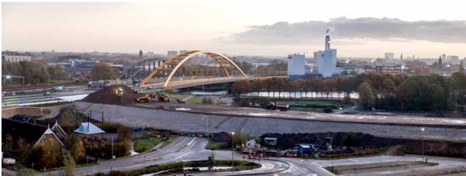
Transport stap 1, van de voorbouwlocatie (rechts) tot aan Vleutensebaan (grondophoging links). Foto Gerrit Serné.
