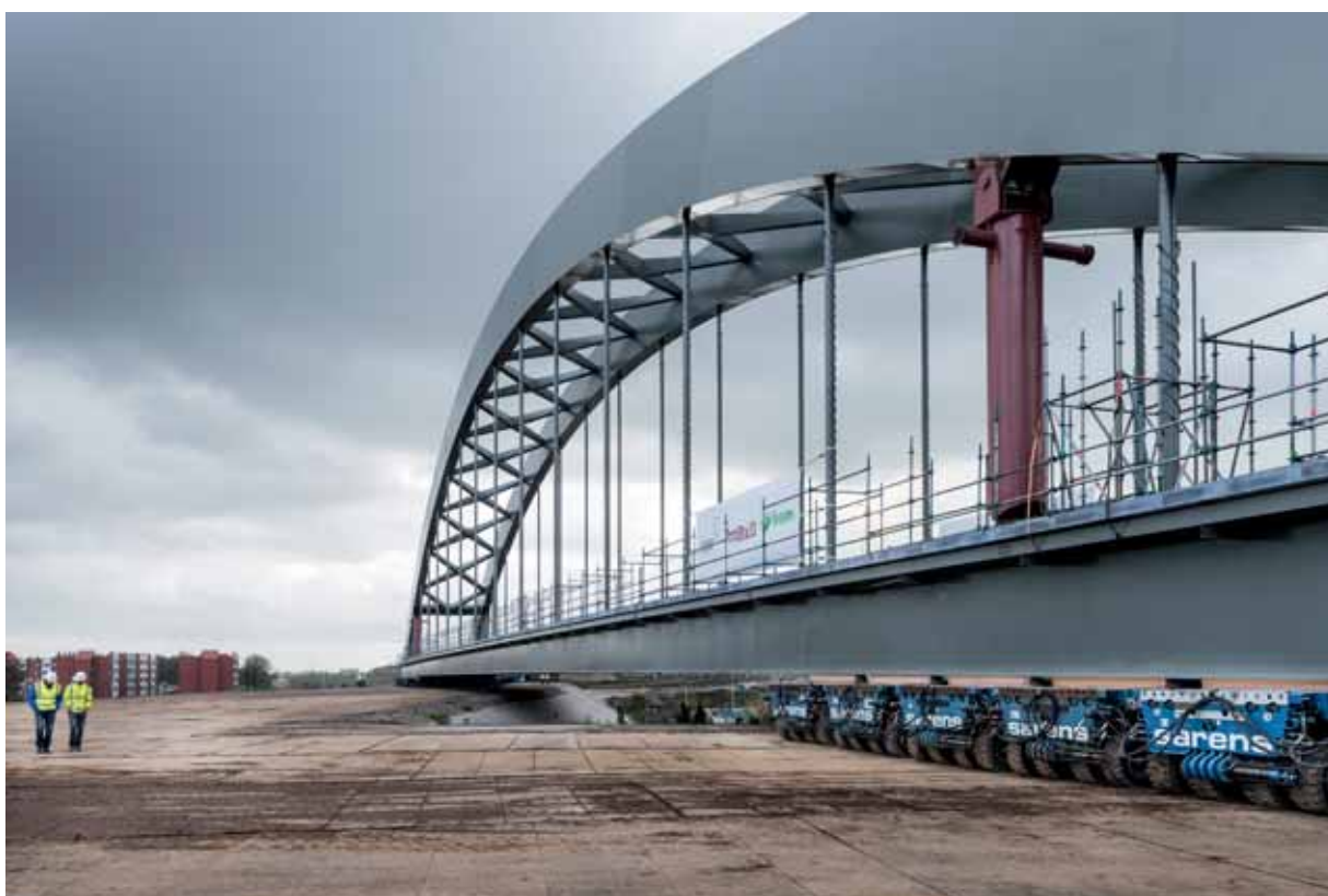
Transport stap 1, van de voorbouwlocatie (rechts) tot aan Vleutensebaan (grondophoging links). Foto Gerrit Serné.
