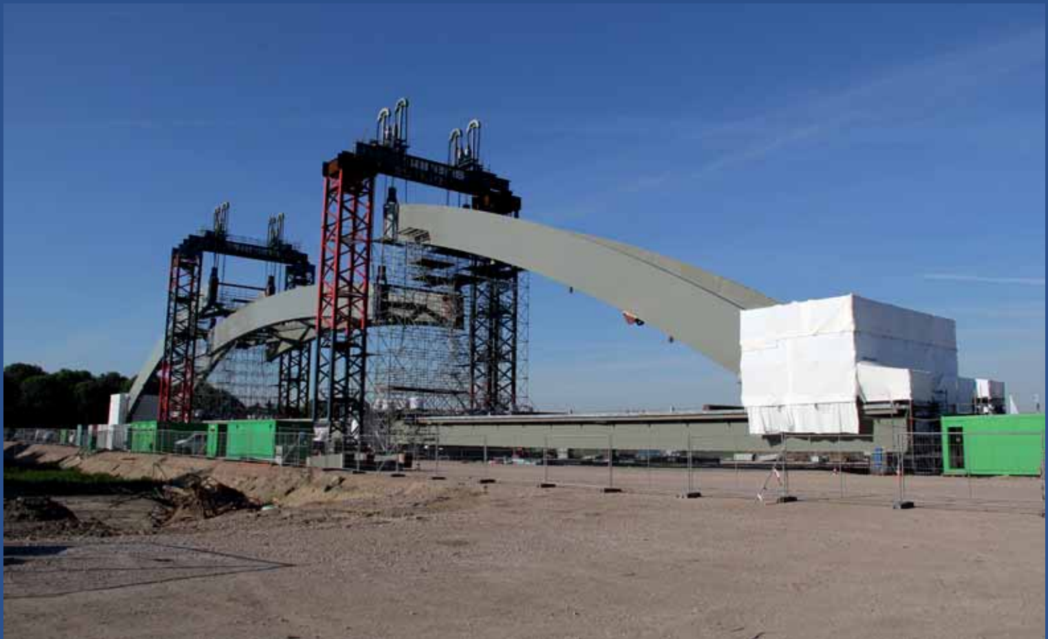
Assemblage van de brugdelen, die in boogdelen worden ingehesen.
