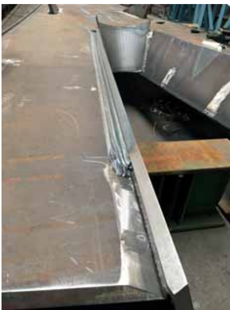
21 Productie van de staalconstructie
