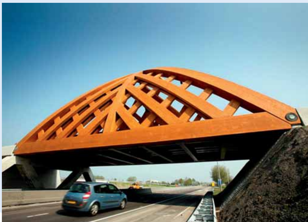
Viaduct van accoya-hout (Sneek).
