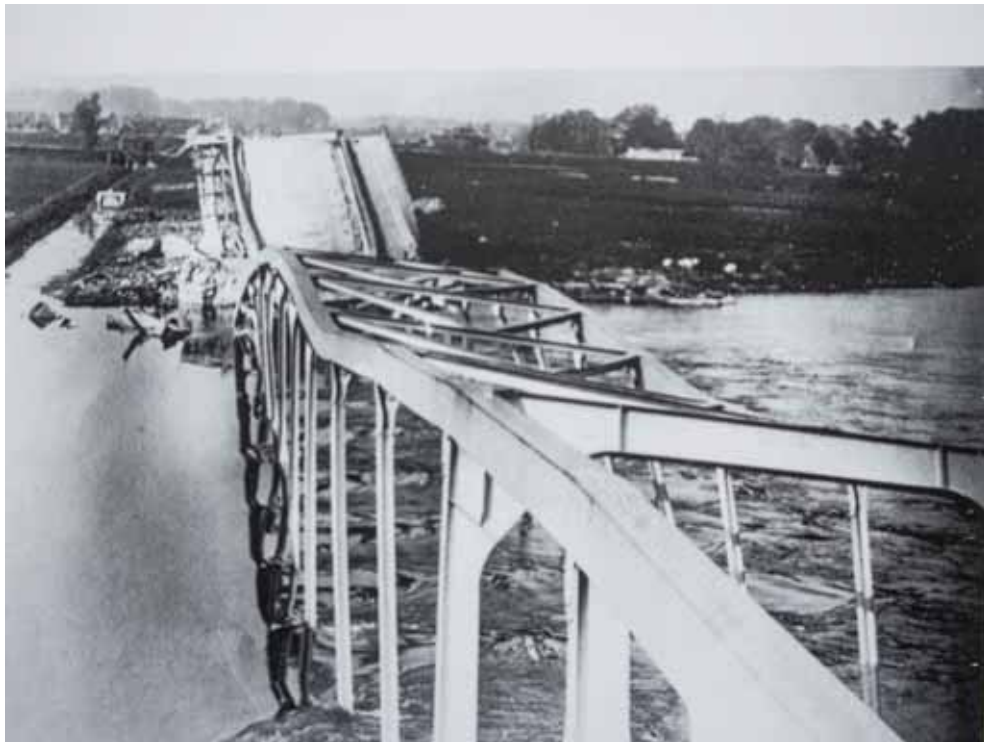
De opgeblazen verkeersbrug in 1945, bron [2].
