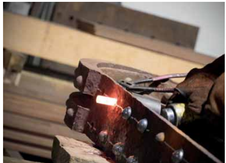
13.a Aanbrengen klinknagel. (© dBdG)
