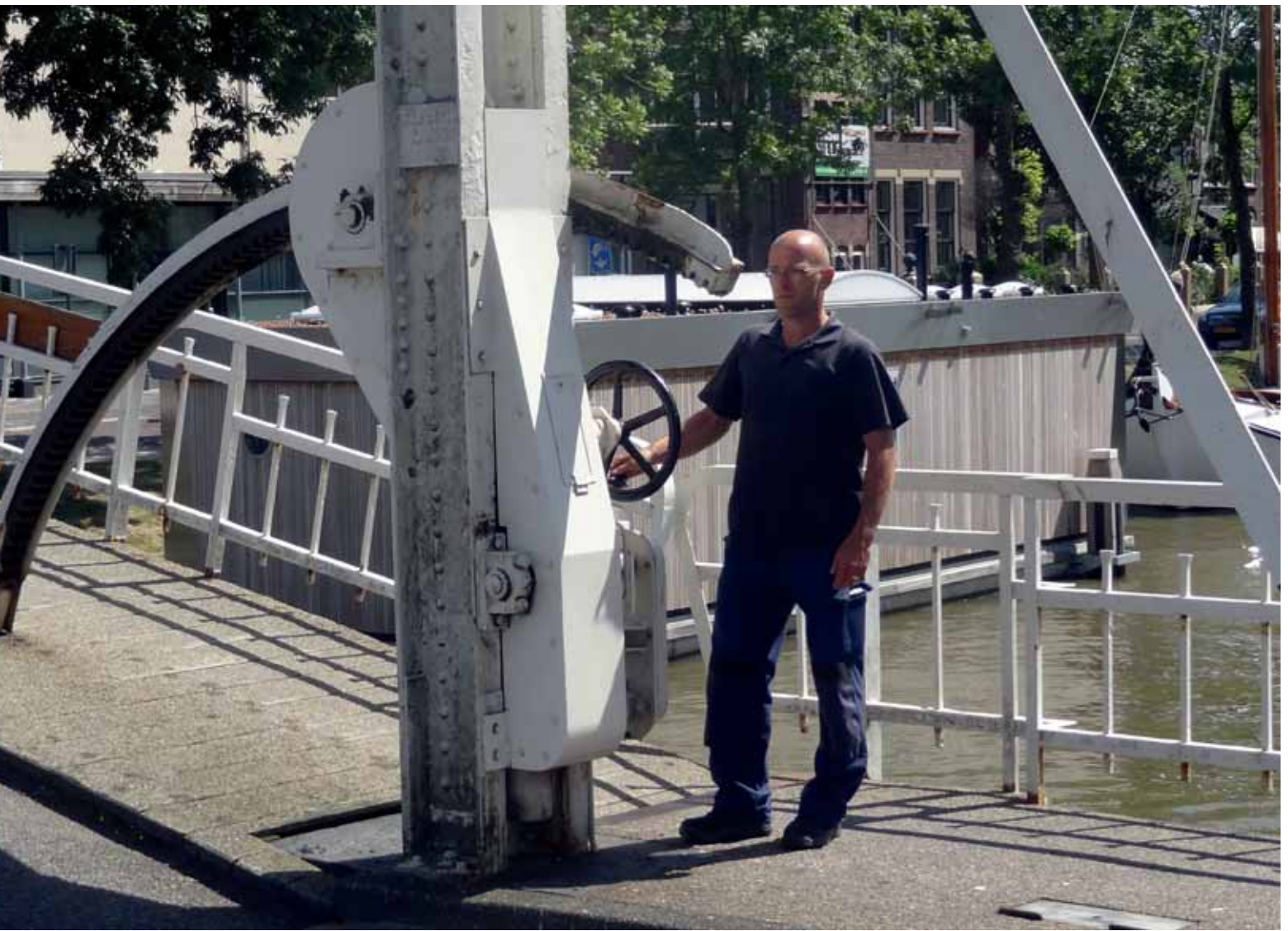
7 Bewegingswerk Oosterbrug met hydraulische motor; de balustrade dateert uit 1952 (© Ars)
