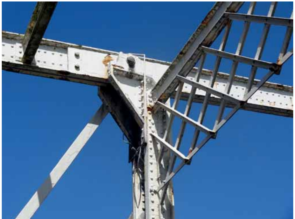
↑↓ 5 a en b Oosterbrug: detail hameipoort met vakwerk hameiregel en draaipunt balans. (© Ars)
