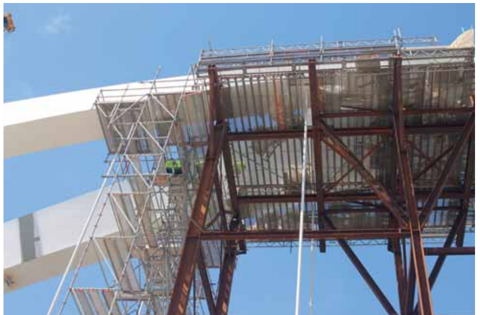
10 Ondersteuning boog op voorbouwlocatie
