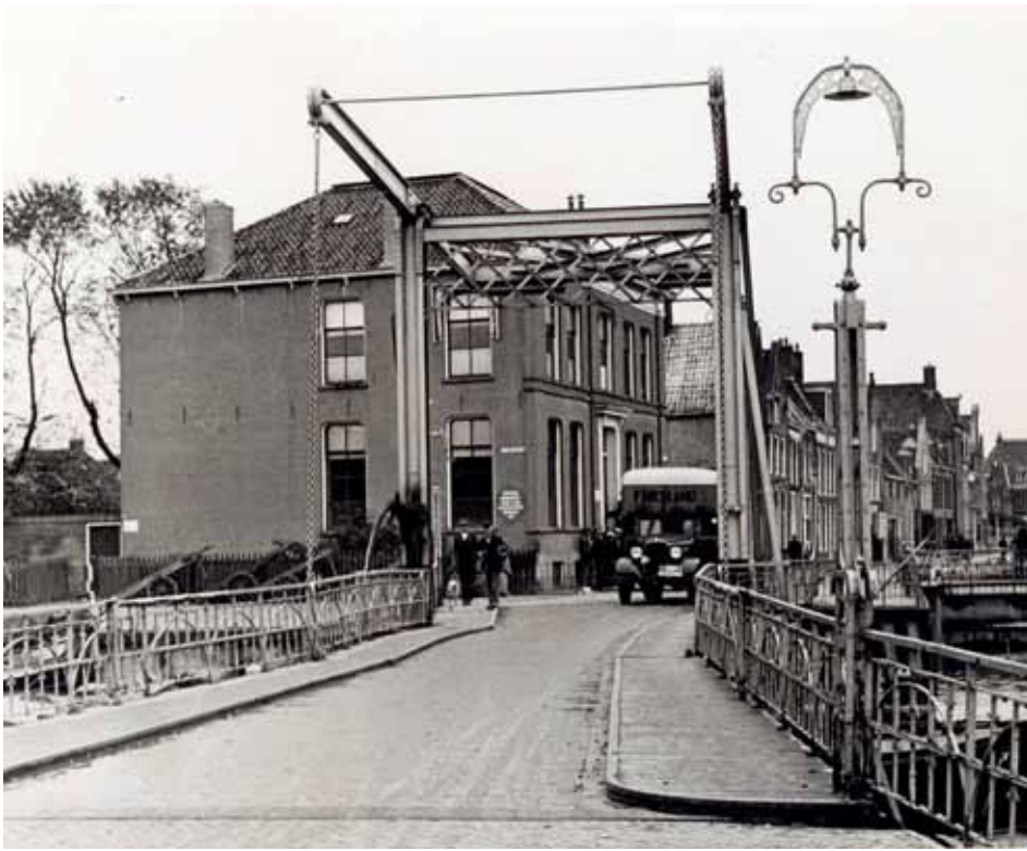
3 Oosterbrug voor de verbreding in 1952 met oorspronkelijk hekwerk. (© MSH)
