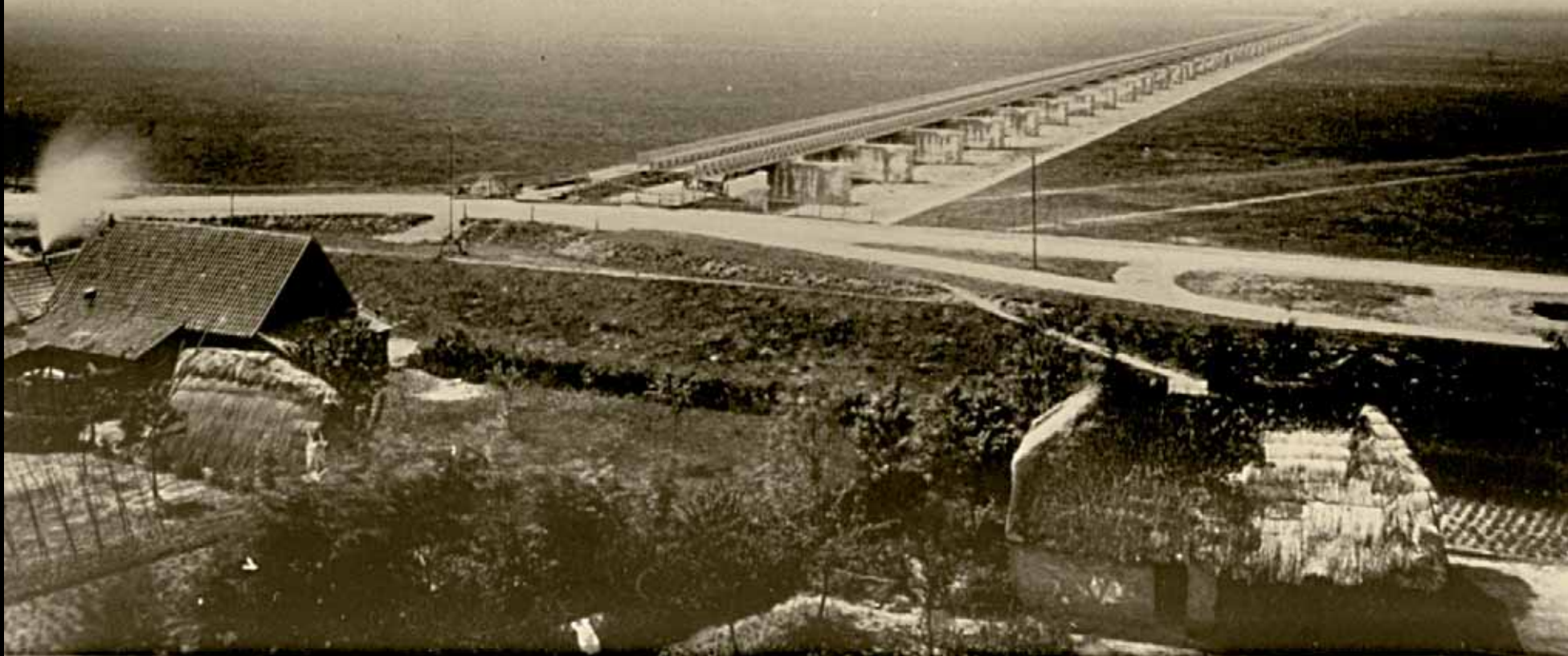
DOORLAATBRUG OVER DEN BAARDWIJKSCHEN OVERLAAT.
