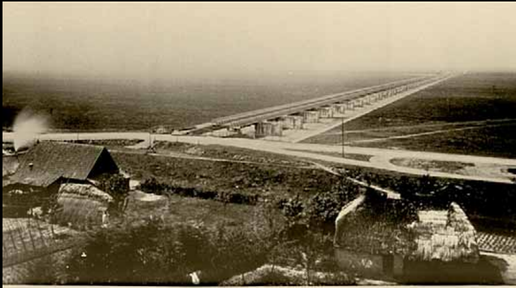
DOORLAATBRUG OVER DEN BAARDWIJKSCHEN OVERLAAT.
