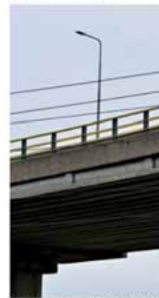
Inspectie aan een viaduct, foto ter illustratie. © Foto: VRPress / ANP
