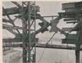
Fig. 14. Aanzicht op het middeelstuk van de brug.
