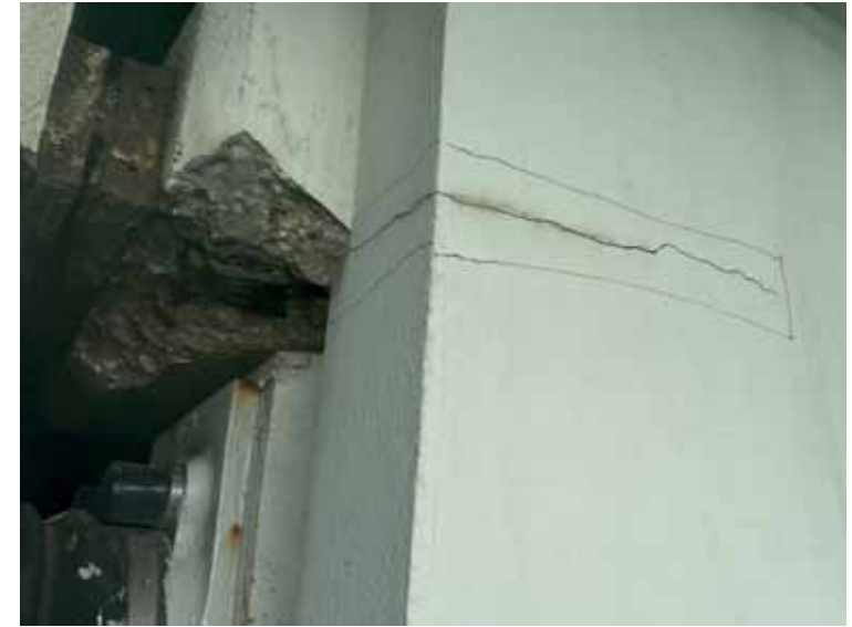
Betonscheuren Verbindingselementen
