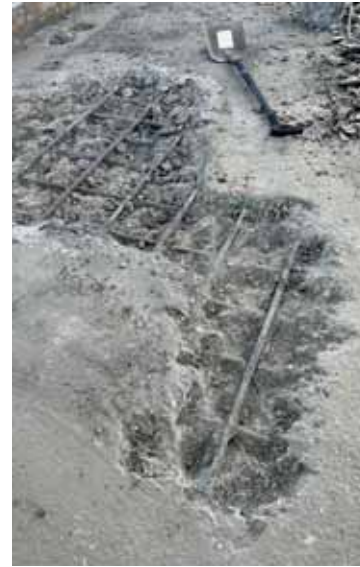
Betonschade (dekking) Liggers & caissons
