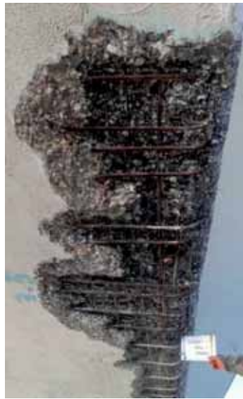
Betonschade (dekking) Liggers & caissons
