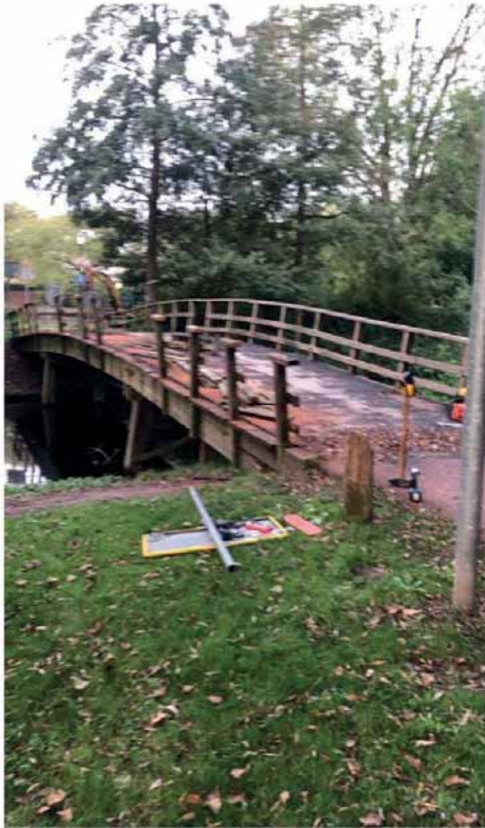
Fiets-/voetgangersbrug in het park
