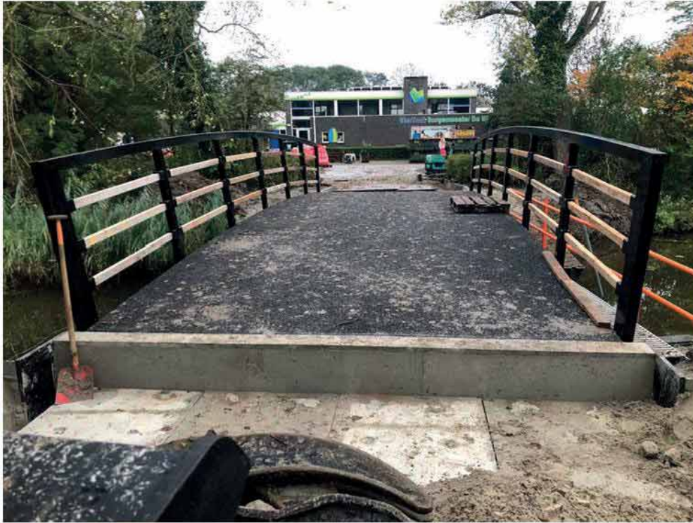
Net geplaatste nieuwe brug (Fibercore)
