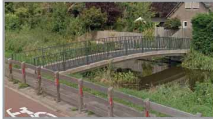
KW 0616, betonbrug Sint Maartenweg
