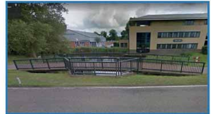
KW 0129, stalen brug Zuidenweg, Schagen
