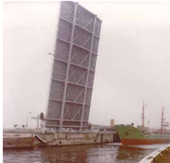
Basculebrug over de Westsluis in Terneuzen.
