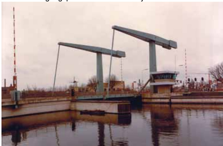
Ophaalbrug over het Kanaal door Walcheren in Middelbrug. (Foto: Hoofddirectie v.d. Waterstaat bur. Reprografie)
