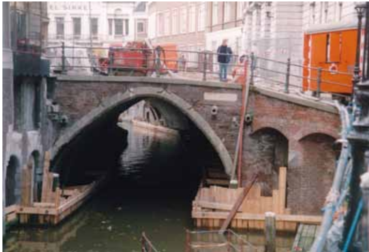
De Huidenbru. Aan de rechterzijde de vleugelmuur met gewelfbogen (Foto: R.J. Roelofs)
