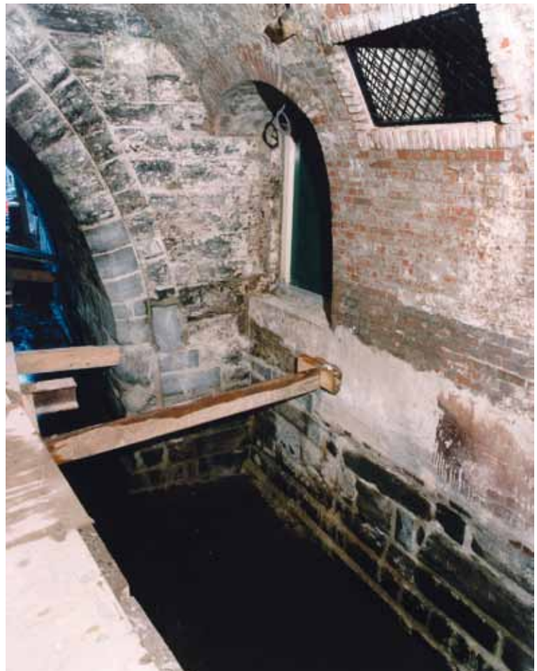
Detail van de aansluiting van het 16e eeuwse brugdeel op de Huidenbrug. De natuurstenen voet onder de 16e eeuwse brug is het restant van een hoog opgaande muur, waarvan de intanding in het front van de Huidenbrug nog te volgen is. (Fotodienst het Utrechts Archief)
