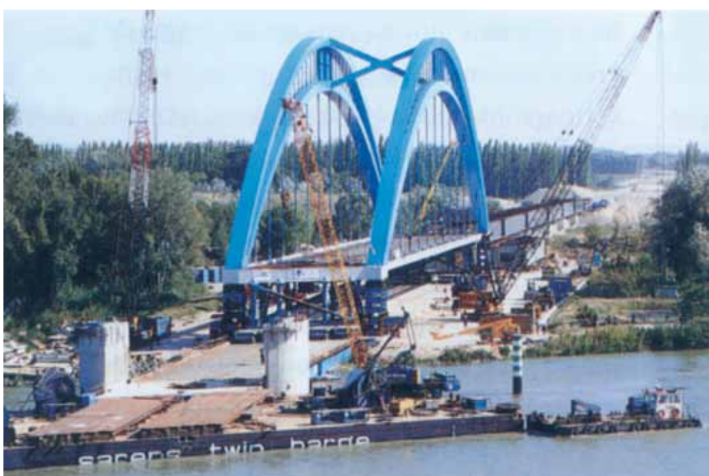
Figuur 3b Frankrijk, Mornas; TGV-spoorbrug
