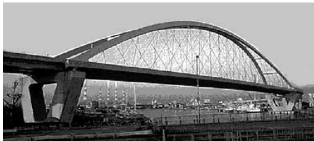
Figuur 8 Verkeersbrug bij Osaka: type Nielsen-Lohse
