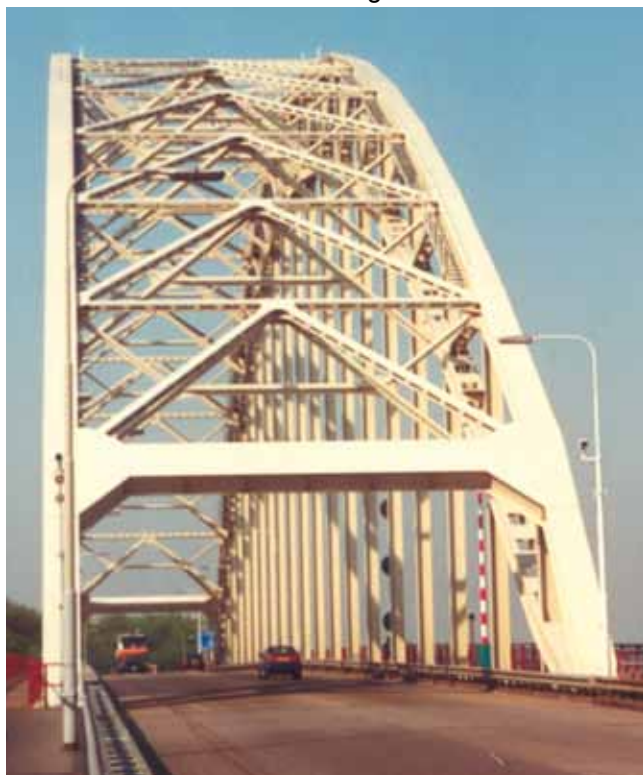
Figuur 23a toepassing van eindportaal in het vlak van de boog.
