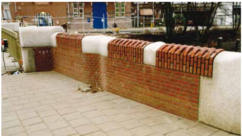
Fraai metselwerk voor de balustraden.
