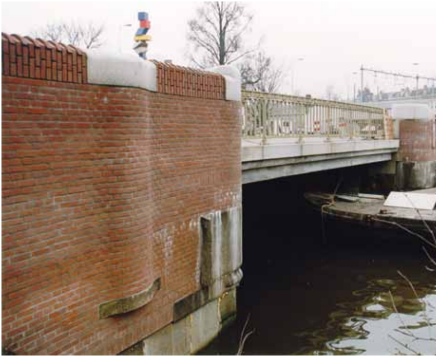
De uitstulping van de borstwering ter plaatse van de lichtmasten.
