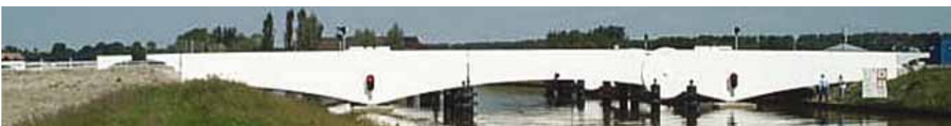
Boven: Het draaipunt ligt op een overkraging van de aanbrug. Onder: Overzicht
