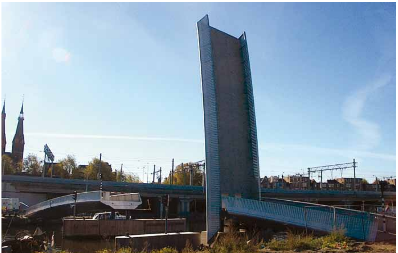
De fiets- en voetgangersbrug Westerdokssluis
